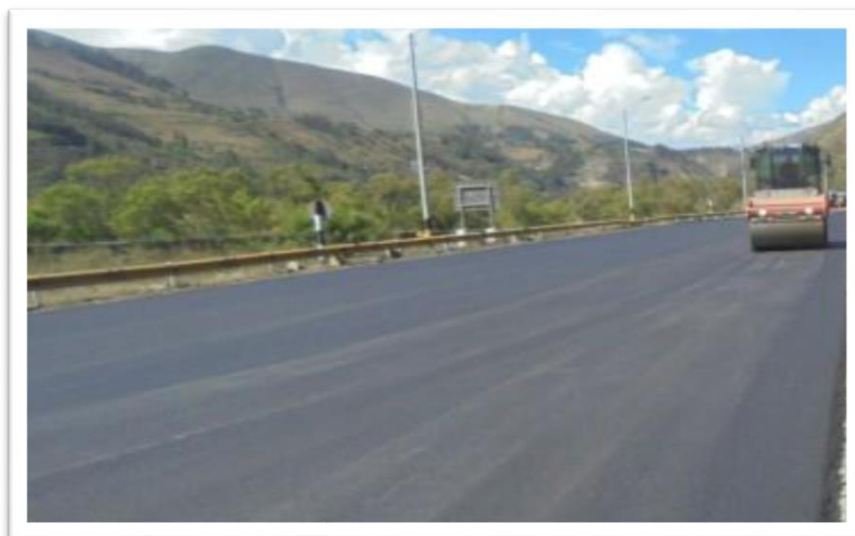
Imagen n° 3. Vía asfaltada terminada
