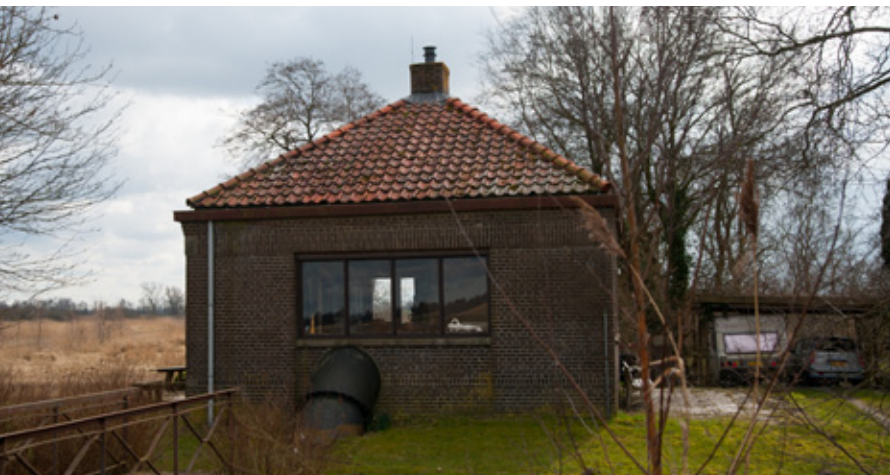
Afbeelding 67 Het voormalige Noordergemaal en machinistenhuisje van de Grootte veenpolder, bij het Kromme Gat aan de Buitendijken, heeft tegenwoordig een recreatieve bestemming.
