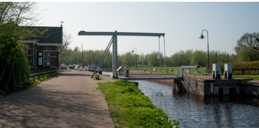
Afbeelding 55 De sluis van Buitenstverlaat is recent gerestaureerd. Samen met het sluishuis en de twee eeuwen oude scheepswerf vormt het een gaaf ensemble.
