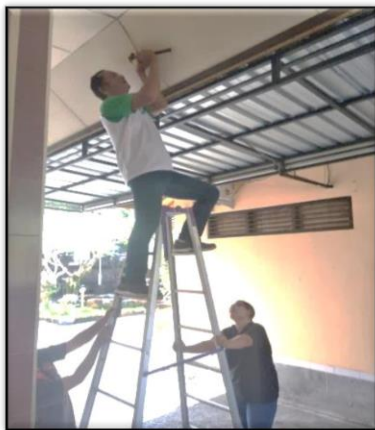
Gambar1. Foto Kegiatan Pemasangan Jaringan
