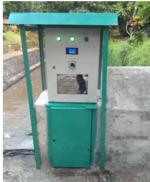
Gambar 8. Instalasi box listrik
