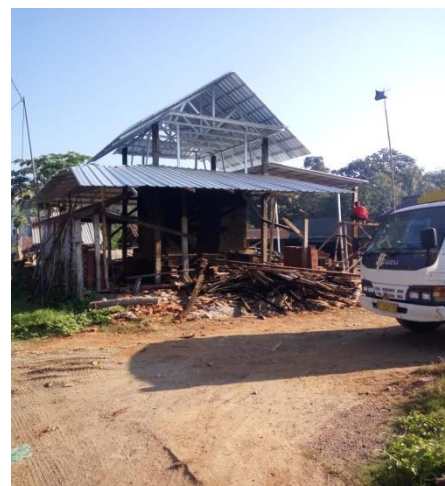
Gambar 6 Tungku Pembakaran yang Atap Penutup Menggunakan Spandex (Setelah Perbaikan)
