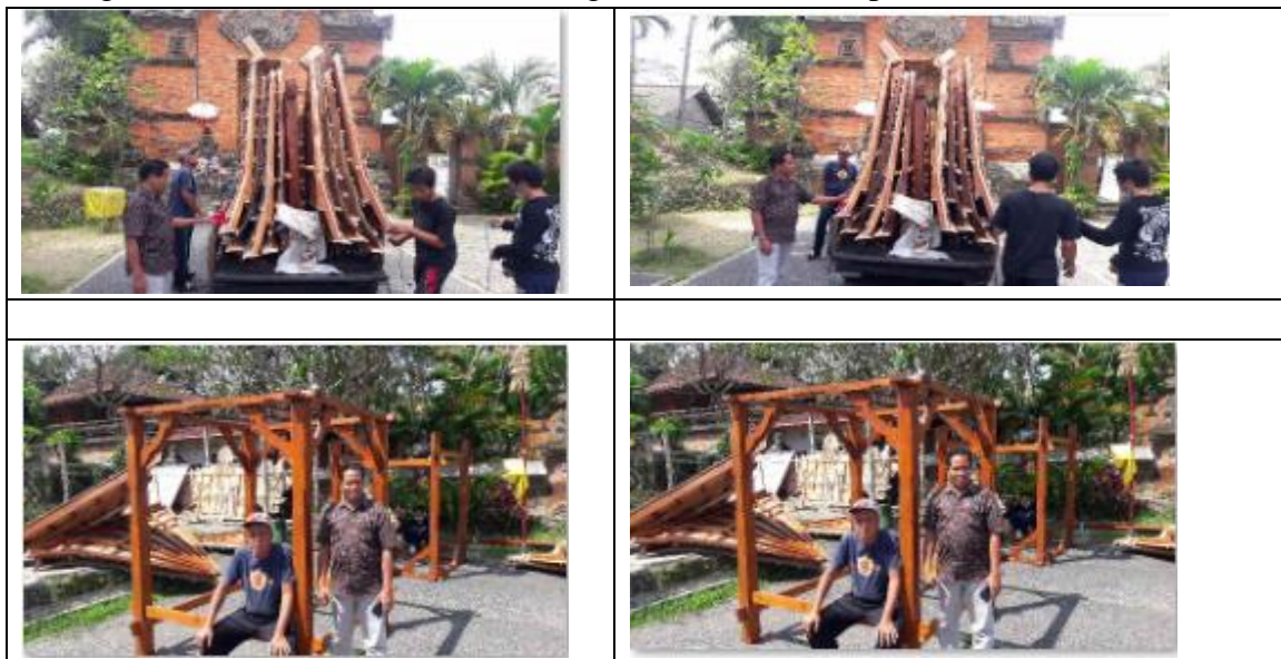
Gambar 2. Instalasi unit gazebo wisata
