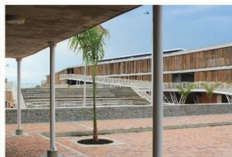
Aterramiento en partes comunes
