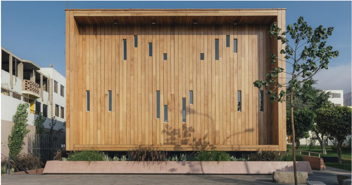
Acercamiento de fachada 2
