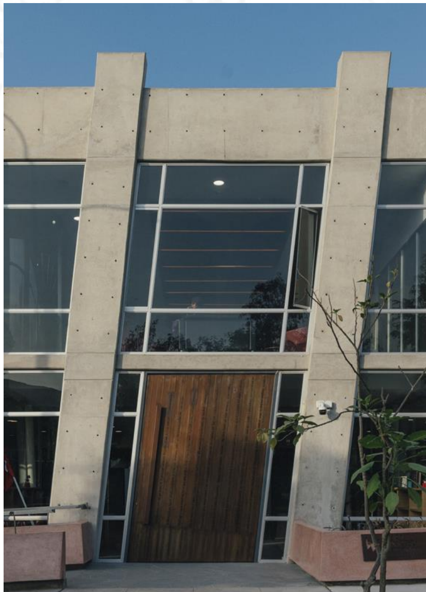
Acercamiento de fachada 1
