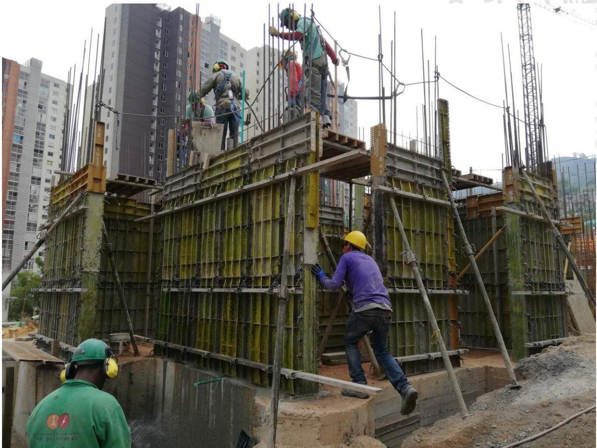
Foto 3. Armado de la formaleta.
