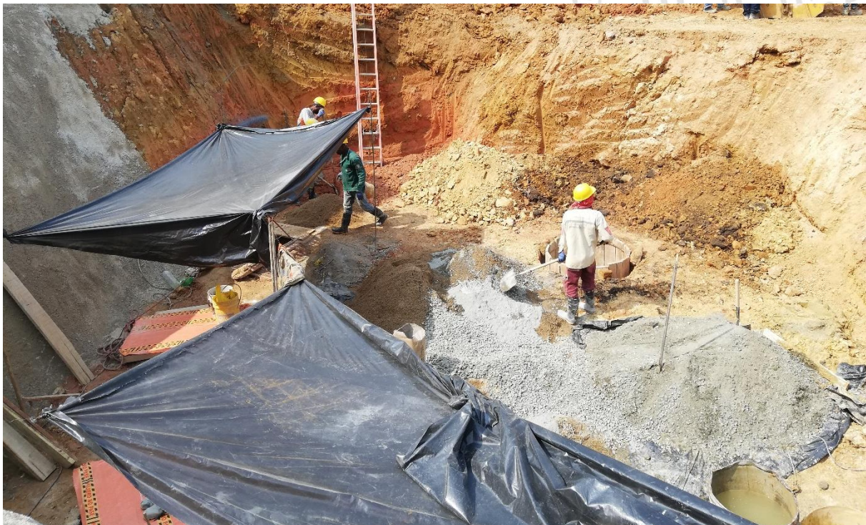
Foto 2. Vaciado de pilas
