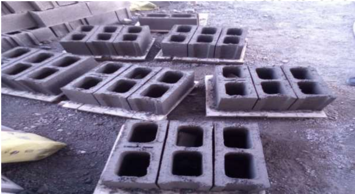
Figura 22. Curado de los bloques de concreto y RCD. Fuente: Autor
