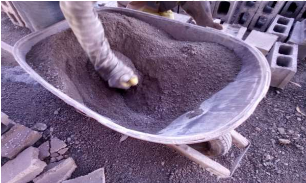
Figura 20. Proceso de mezclado manual en seco. Fuente: Autor
