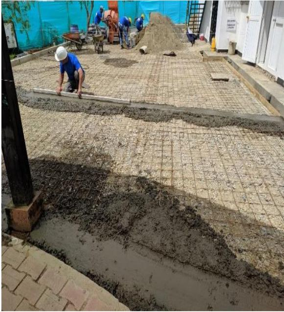
*Figura 103.* Suministro e instalación de malla electrosoldada parqueadero trasero (ITEM OE4).
