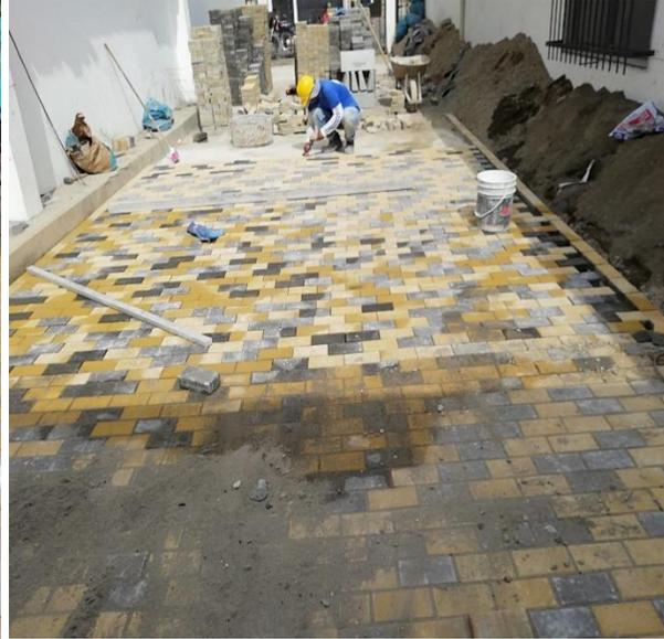
*Figura 108.* Suministro e instalación de adoquín vehicular parqueadero frontal (ITEM 12-OBRA).
