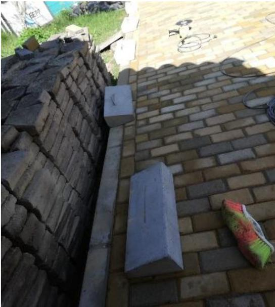
*Figura 109.* Instalación de topellanta en concreto (ITEM 19-OBRA).
