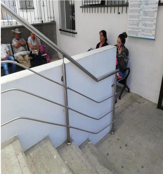
*Figura 89.* Asegurada, suministro e instalación de barandas en acero inoxidable (ITEM 20).
