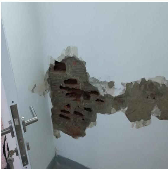
*Figura 83.* Canchado de muros inspección de humedad (ITEM 17).
