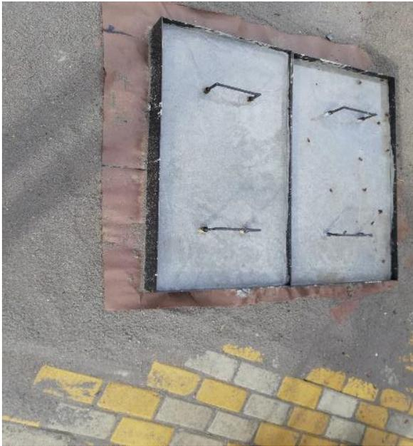
*Figura 111.* Tapas de cajas de inspección sanitaria (ITEM EO13).
