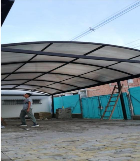
*Figura 117.* Cubierto en policarbonato parqueadero ambulancia (ITEM 14-OBRA).
