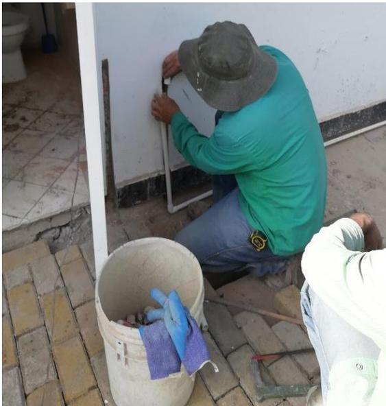
*Figura 121.* Tubería hidráulica de 1/2" (ITEM 8-OBRA).
