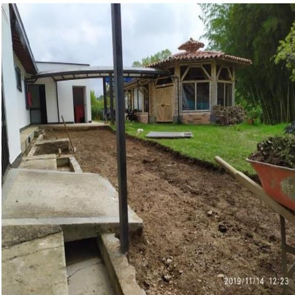
*Figura 97.* Excavación y nivelación parqueadero trasero ambulancia (ITEM OE1).
