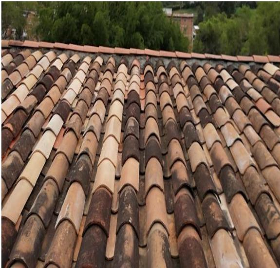
*Figura 81.* Instalación de cubierta en teja de barro (ITEM 16).
