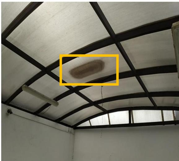
*Figura 12.* Suciedades en cubierta de policarbonato.
