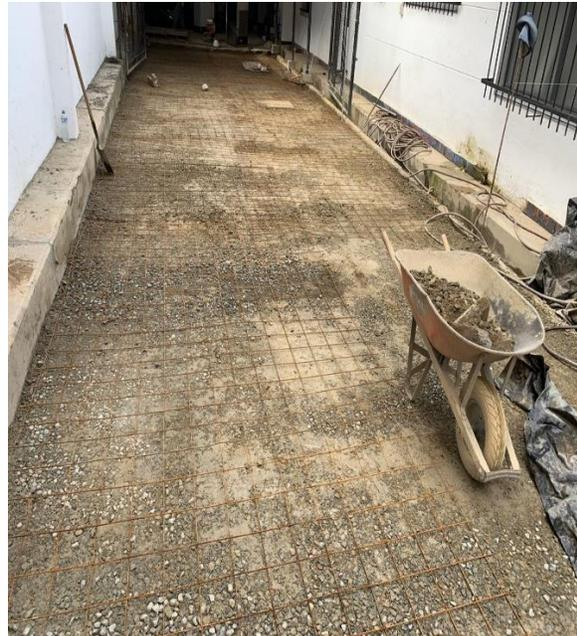
*Figura 104.* Suministro e instalación de malla electrosoldada parqueadero frontal (ITEM OE5).
