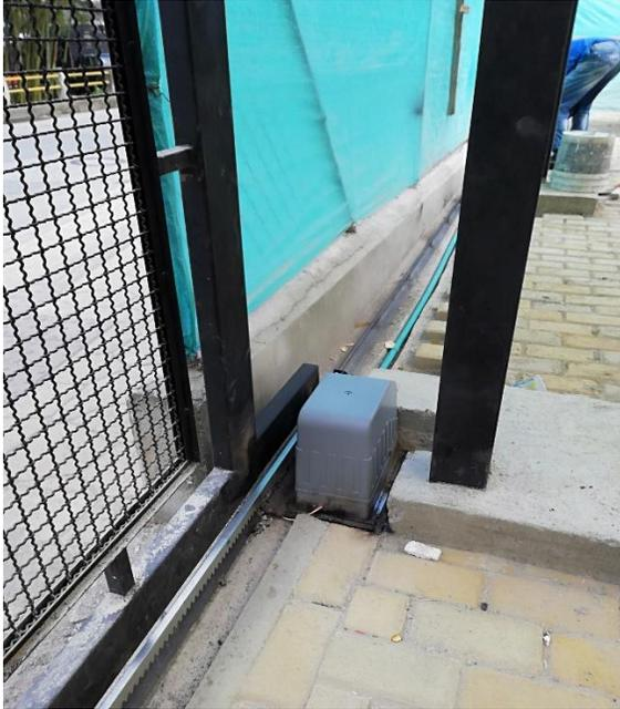
*Figura 127.* Instalación de motor para portada corrediza (ITEM OE8).
