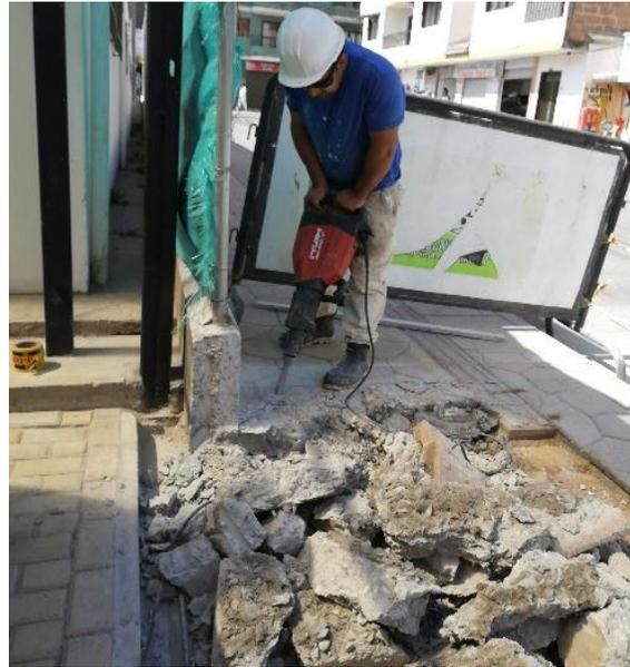
*Figura 124.* Demolición andén peatonal en concreto estampado (ITEM OE15).
