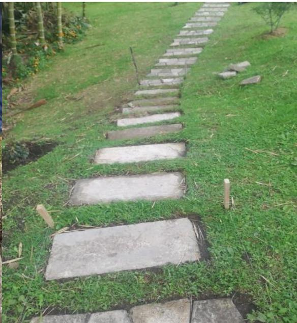
*Figura 94.* Reinstalación de adoquín en sendero peatonal (ITEM OE7).
