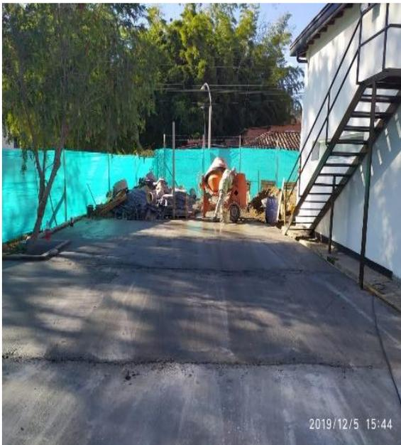
*Figura 105.* Losa en concreto de 21 Mpa parqueadero trasero (ITEM OE5).
