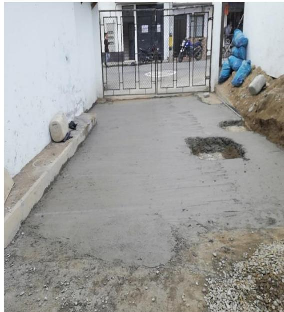
*Figura 106.* Losa en concreto de 21Mpa parqueadero frontal (ITEM OE5).
