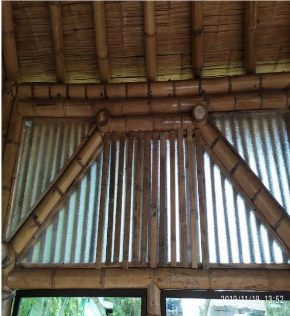
*Figura 75.* Instalación de cerramiento en quiosco (ITEM 26).
