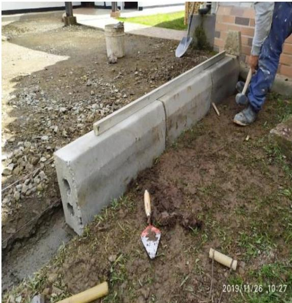
*Figura 101.* Suministro e instalación de bordillos (ITEM OE3).
