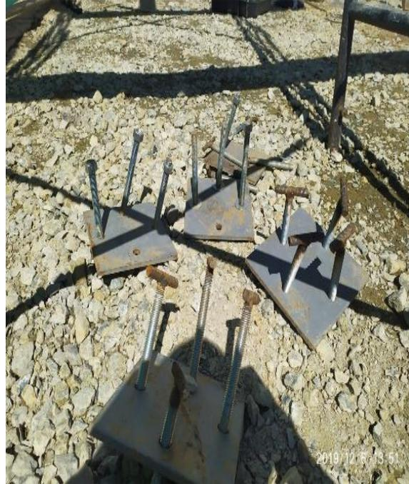
*Figura 114.* Placa base estructura metálica (ITEM OE6).
