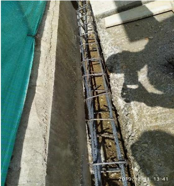
*Figura 123.* Viga de cimentación portada corrediza (ITEM EO9).
