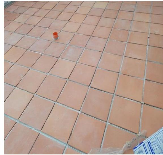
*Figura 132.* Instalación de piso en baldosa colonial antideslizante (ITEM EO14).
