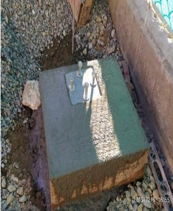
*Figura 113.* Pedestal en concreto 50x50x50 soporte estructura (ITEM OE6).
