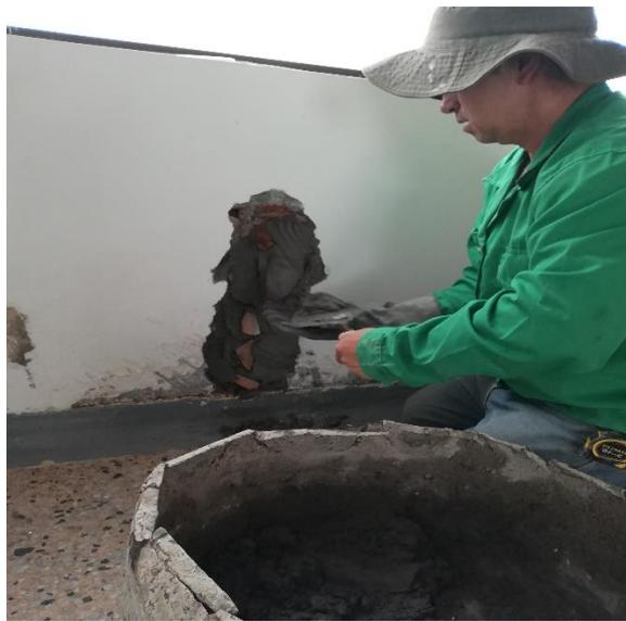
*Figura 84.* Revoque de muros con mortero impermeabilizado (ITEM 17).
