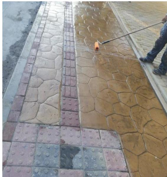
*Figura 126.* Construcción de concreto estampado (ITEM OE14).
