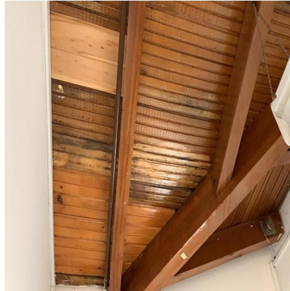
*Figura 80.* Cambio de tablilla machihembrada deteriorada (ITEM 16).
