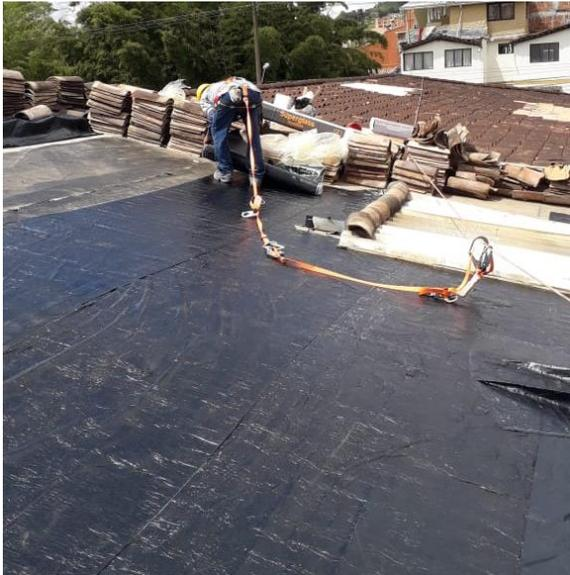
*Figura 79.* Instalación de manto asfáltico impermeable (ITEM 16).
