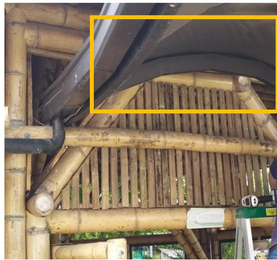
*Figura 13.* Suciedades en cubierta de policarbonato.
