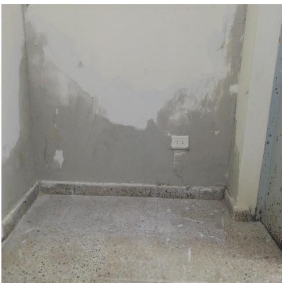
*Figura 85.* Resane de muros con humedad (ITEM 17).
