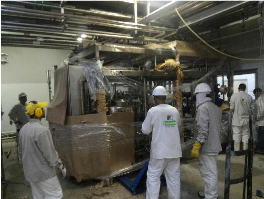
Figura. 46 Montaje de pasteurizador queso blanco
