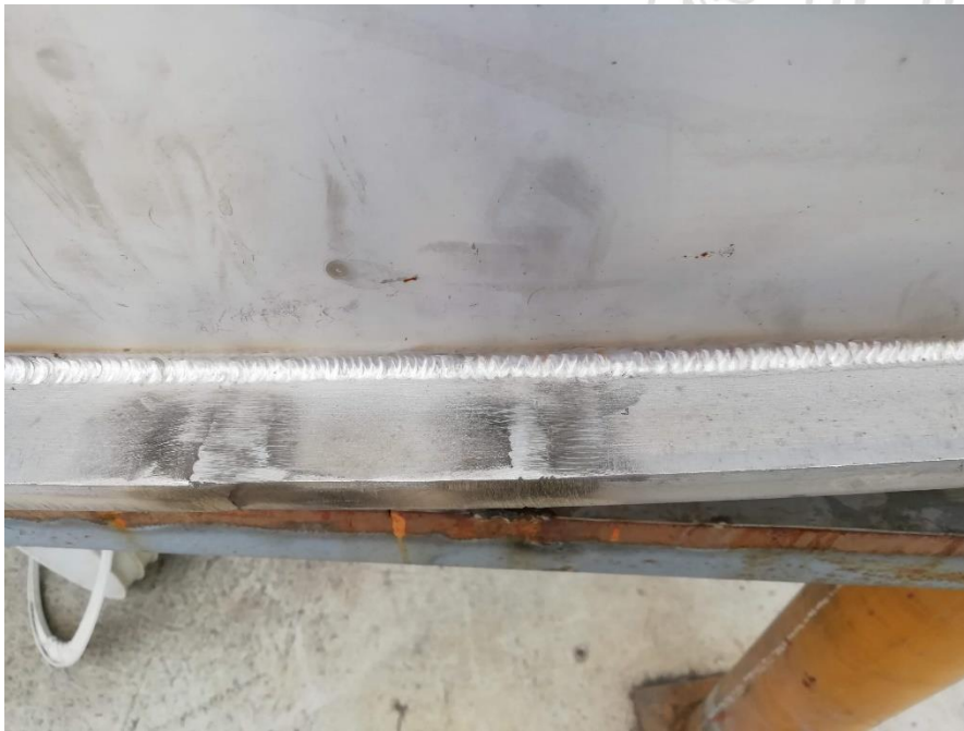
Figura. 41 Inspección visual de cordones de soldadura proceso GTAW
