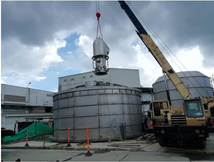
Figura. 40 Montaje ducto aspiración cámara de secado
