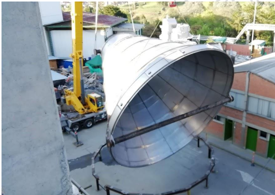
Figura. 43 Izaje cono cámara de secado
