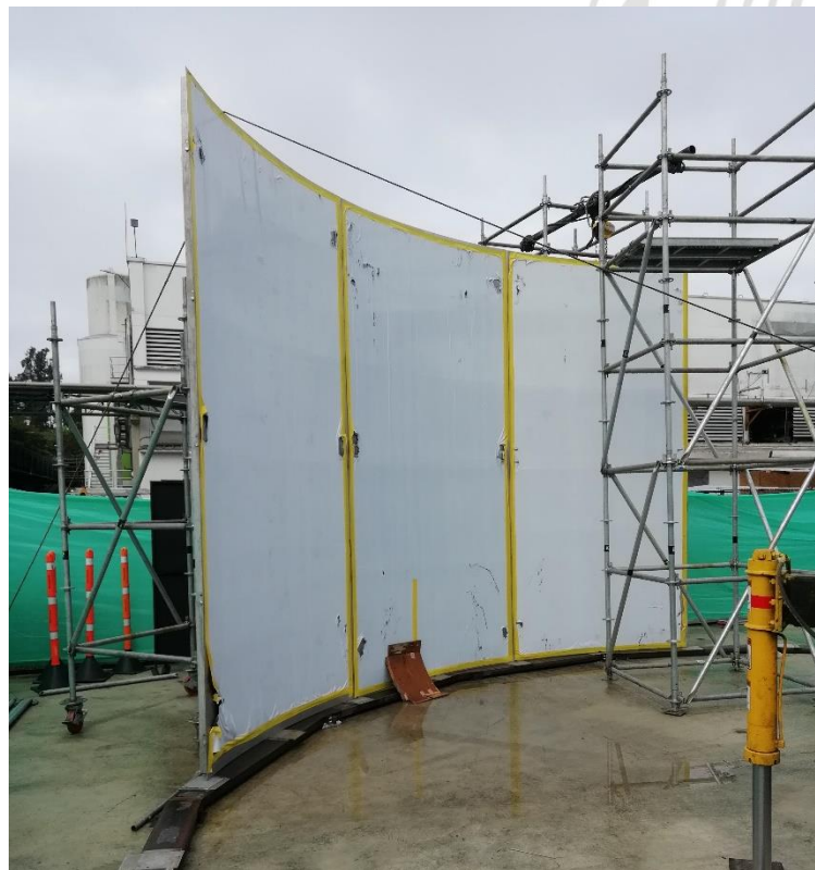
Figura. 39 Inicio montaje cámara de secado
