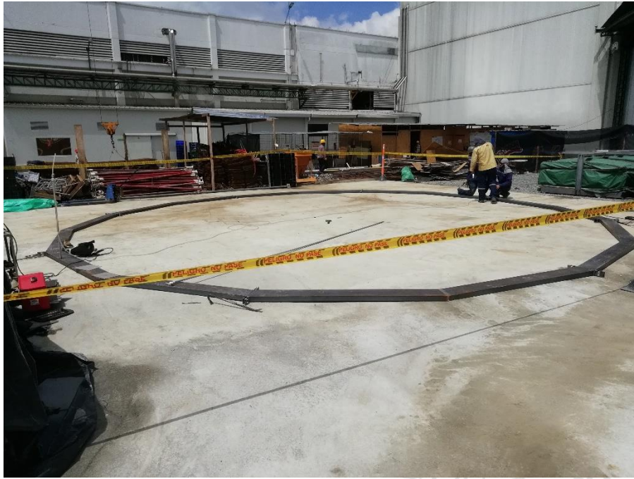
Figura. 38 Preparación de superficie para montaje de equipos
