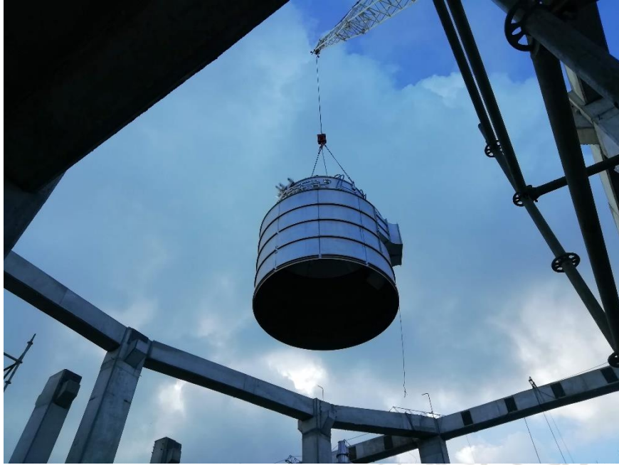
Figura. 42 Izaje filtro de mangas
