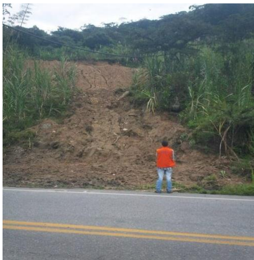
Imagen N° 1. Deslizamiento de tierra sobre la Autopista Medellín – Bogotá, Km 70 vereda La Esperanza
