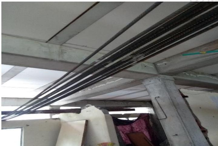
**Ilustración 19. Realce de viga.**
