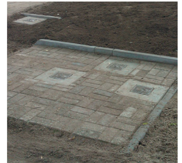
Afbeelding 5.3.b Straatpotten voor de bediening van ondergrondse afsluiters.
