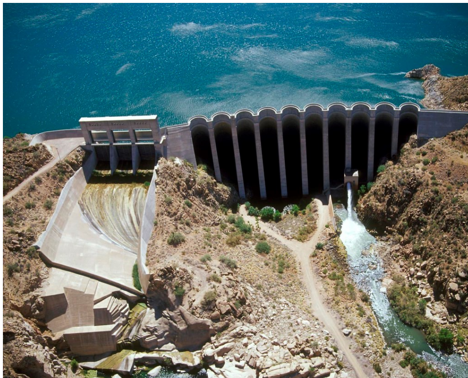
Figure 2.5 Évacuateur de crue du barrage Bartlett, Arizona. © Bureau of Reclamation (2004). Reproduit avec permission
