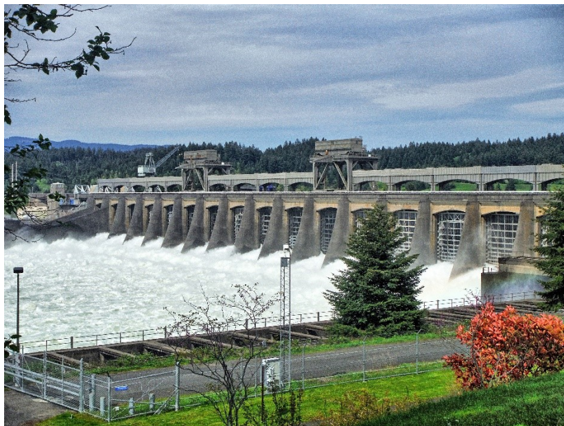
Figure 2.4 Évacuateur du barrage Bonneville, Oregon. © K. Edblom (2014). Reproduit avec permission.
