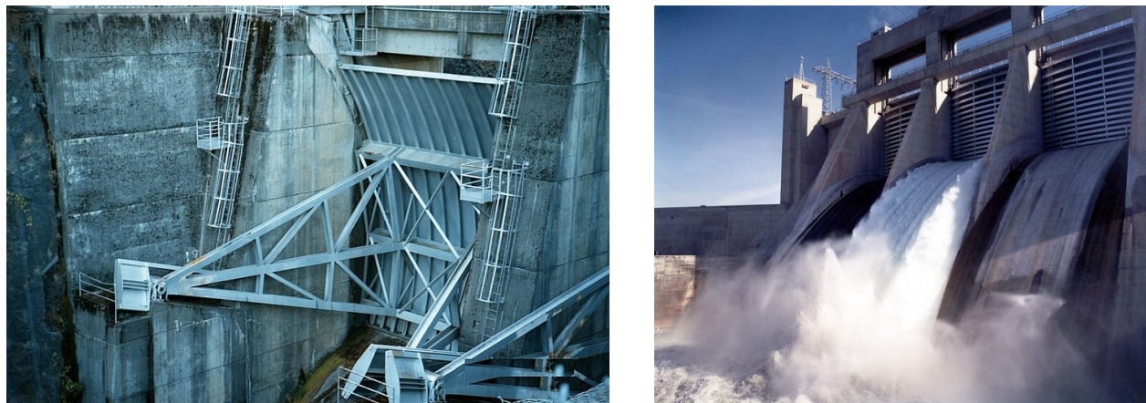
Figure 2.2 Exemples de vannes : (gauche) vanne radiale de l'évacuateur de crue du Cougar Dam, Oregon © R. Ashworth (2013) et (droite) vanne levante de l'évacuateur de crue du barrage Davis, Colorado © Bureau of Reclamation (2013). Reproduits avec permissions.
