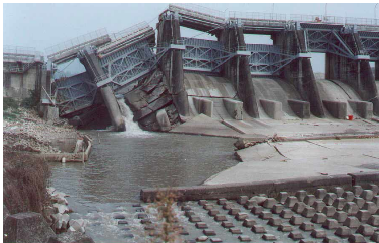
Figure 2.6 Évacuateur de Shih-Kang suite au séisme de Chi Chi (1999), Taïwan. © Wieland et Fan (2004).
