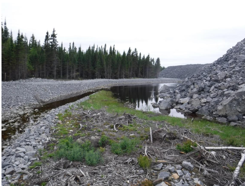
Figure 3.3 : Fossé collecteur au sud du bassin versant NW. Les pentes de la halde mixte sont visibles sur la droite de la photo.
