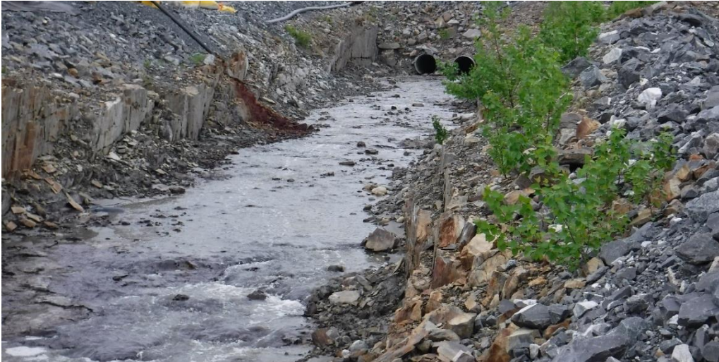
Figure 3.6 : Portion amont du Fossé collecteur Sud excavé dans le roc.
