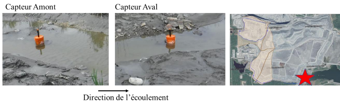
Figure 3.7 : Station de mesure du Sud-Est. Le fossé est chargé de sédiments, la pente est presque nulle et le fossé est beaucoup plus large que pour les stations Nord et Sud. L'emplacement de la station de mesure est indiqué par une étoile rouge sur la photo aérienne à droite.
