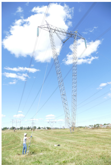
Figure C.1 Pylône en V haubané - Photographie Najib Bouaanani
