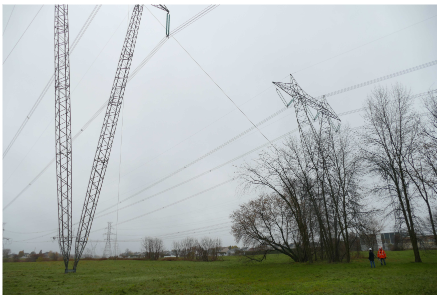
Figure 3.3 Pylône en V haubané de Terrebonne (Photographie par Najib Bouaanani)
