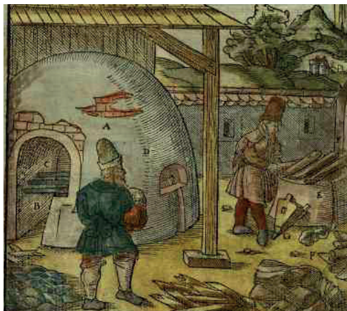
A lengyel és magyar leúzökemence ábrázolása a De re metallicában (10. könyv. 243. ábra)
