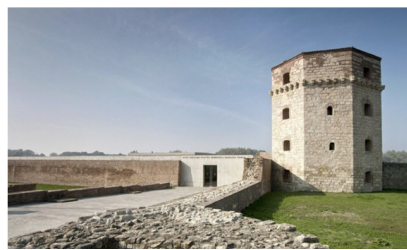
Kép7. Nebojsa torony rehabilitációja és bővítése, Belgrád, Szerbia, 2007-2011. Építésszek: Miljković, Dejan – Mitrović, Jovan – Pavić, Branko. Forrás: www.superprostor.com
