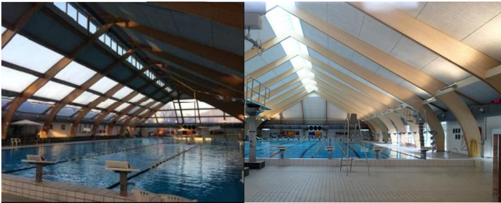
Figur 1. Svømmehallen set indefra før renoveringen (tv) og efter renoveringen (th).
