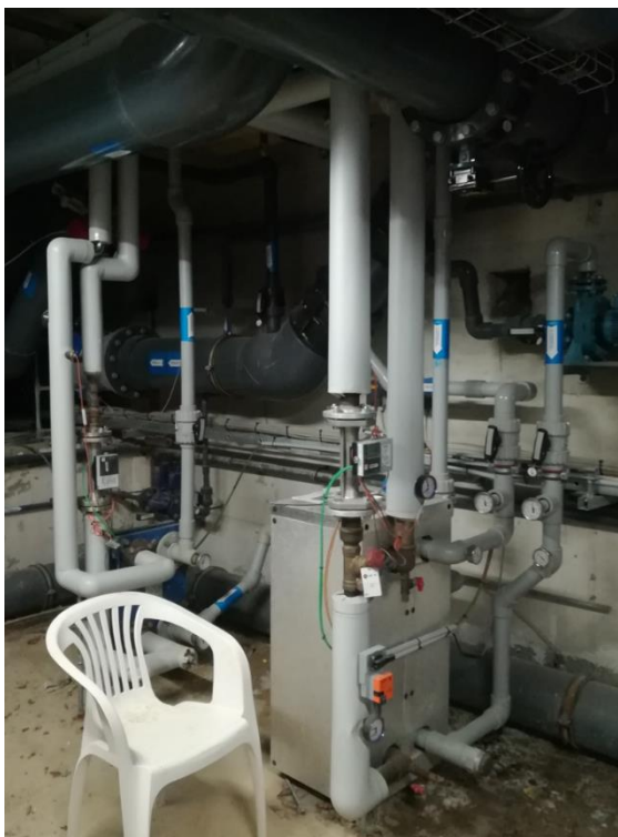
Foto tv: Varmvekslere til svømmebassin (forrest) og varmtvandsbassin (bagerst) i gammel installation. Foto th: Ny veksler på fjernvarmen og rørinstallation for indføring af varme fra varmepumpen.
