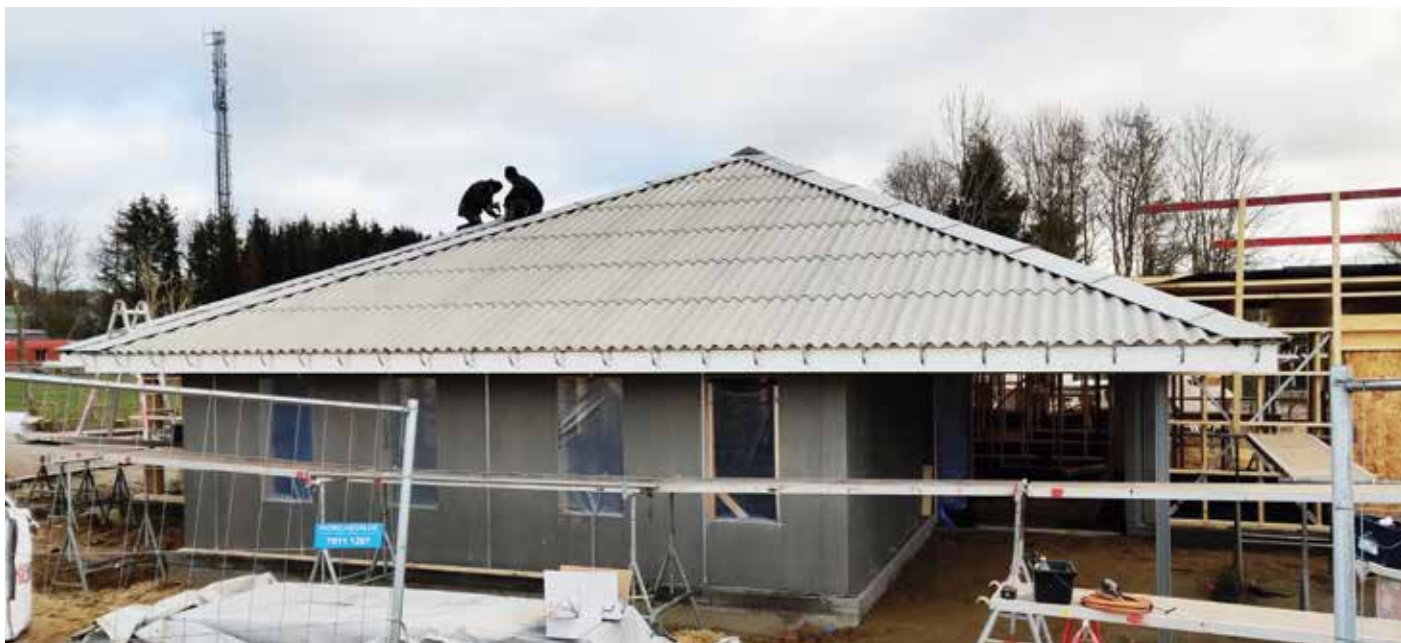
Birkehuset Ry er opført med vindspærreplader i fibercement frem for vindgips. Det gør institutionen både grøn og indeklimavenlig.
