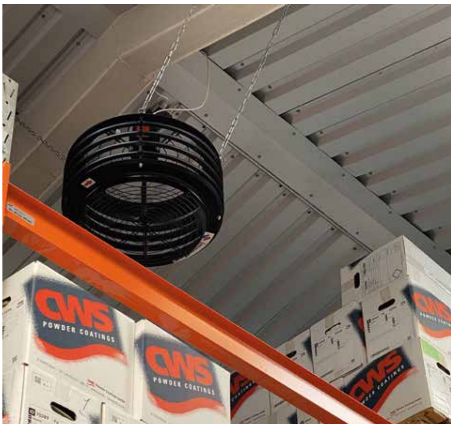
Eliturbo monteret under loftet cirkulerer varmen ned i arbejdshøjde, hvor den gør gavn.
