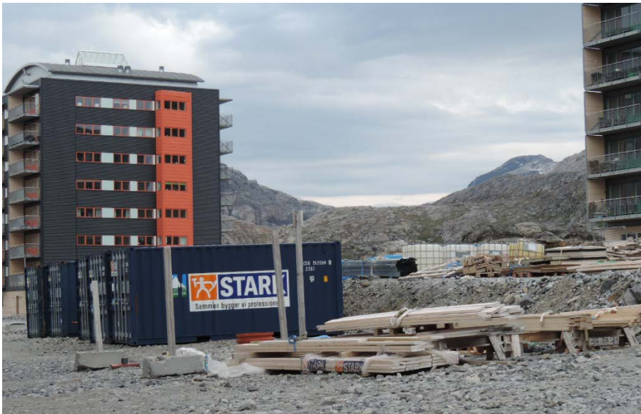
Figur 11. Byggepladser i Grønland ligner danske byggepladser, idet kun få byggevarer og materiel er overdækket.
