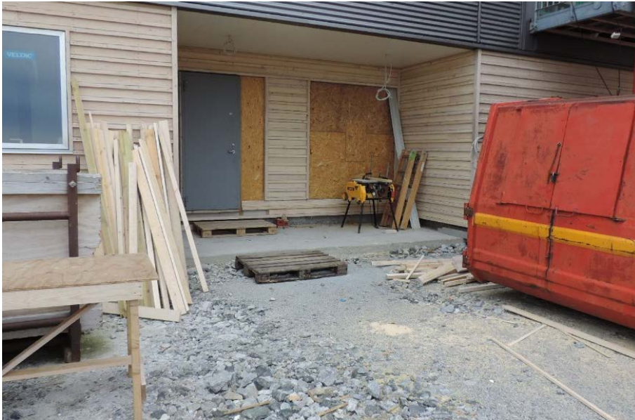
Figur 10. Der kunne i begrænset omfang arbejdes med overdækkede produktionsområder på byggepladsen, idet udførelse foregår direkte i og på bygningen. I Danmark er der flere produktionsområder på byggepladsen uden for bygningen, og de er ofte overdækkede.
