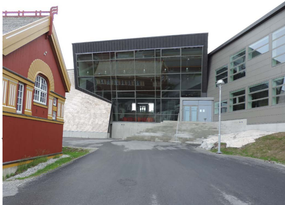
Figur 12. Om- og tilbygning i 2010-12 til gymnasiet i Nuuk til en samlet byggesum på 73 mio. kr. for de 2.600 m 2 .
