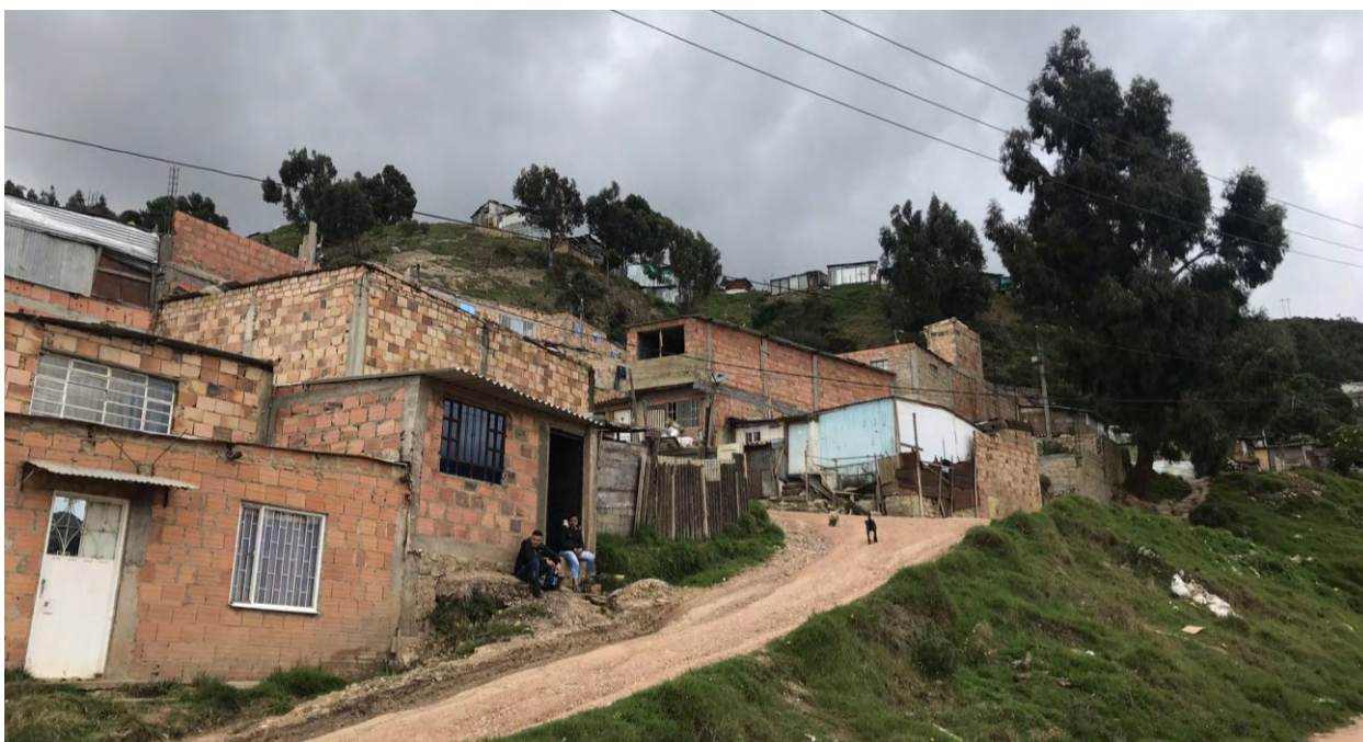
Figura 63 Zona apta baja. Barrio Sierra Morena, Localidad de Usme Fuente: Archivo personal (mayo 2018)
