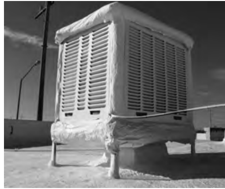
Figuras 4a y 4b. Aislamiento en equipo de enfriamiento. Izquierda: Equipo de EED; derecha: Tanque de almacenamiento de agua (Luis Carlos Herrera Sosa).
