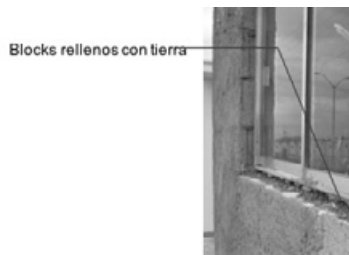
Figuras 6a y 6b. Masa térmica en muros. Izquierda: Sección; Centro: Detalle; Derecha: Vista exterior (Luis Carlos Herrera Sosa).
