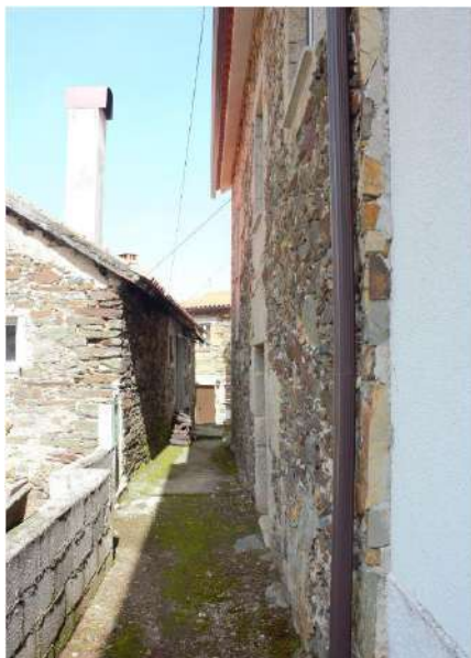
Figura 49: Caminho traseiro formado pelas casas
