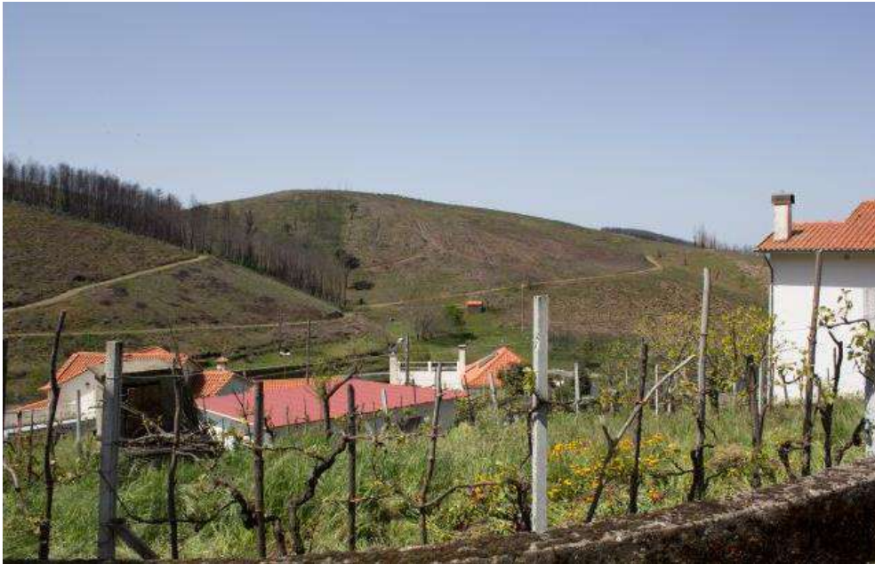
Figura 44: Vista da rua, Goulinho
