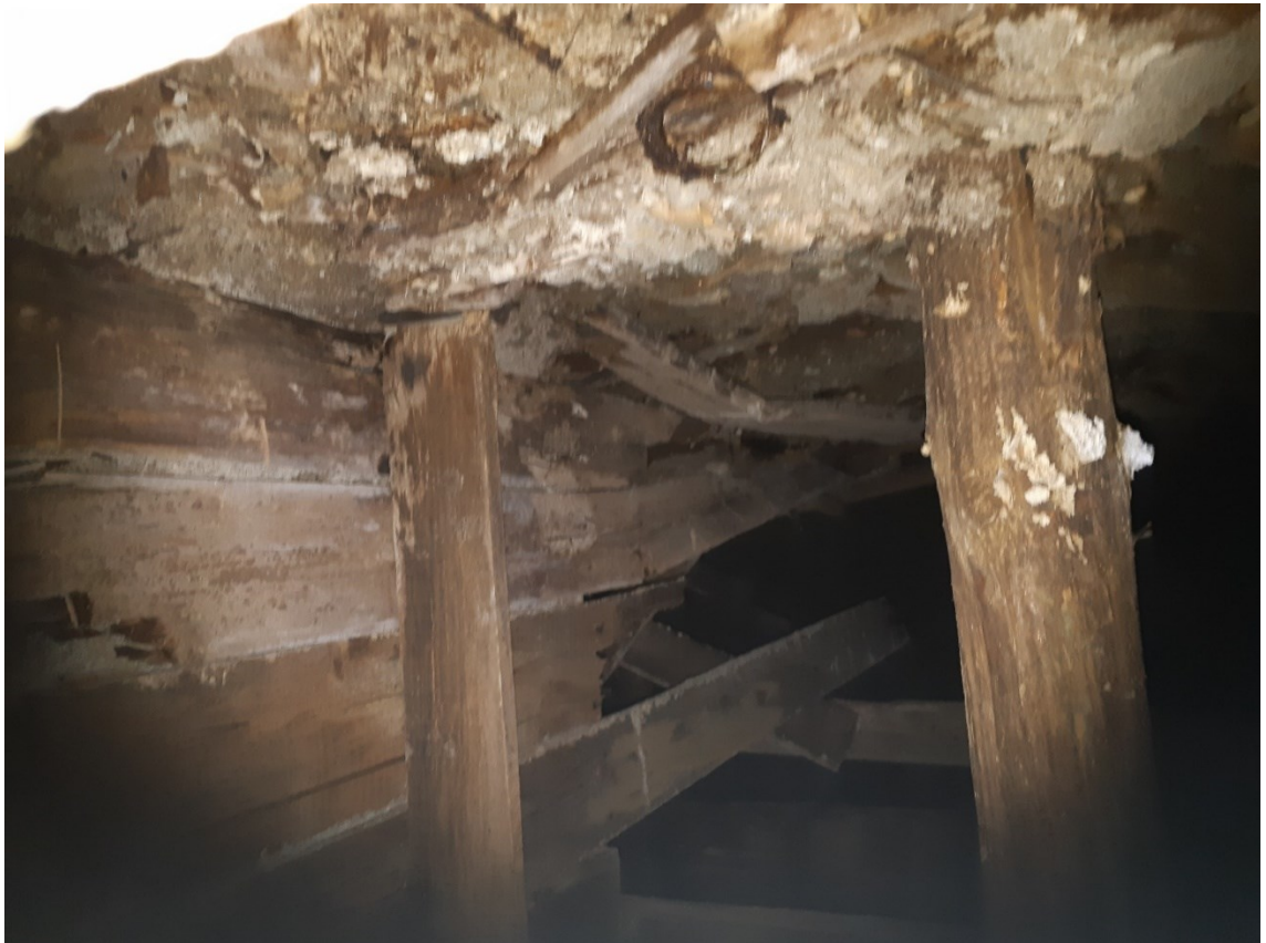
Kuva 2. Mikrobikasvusto rakennuksen alapohjassa
