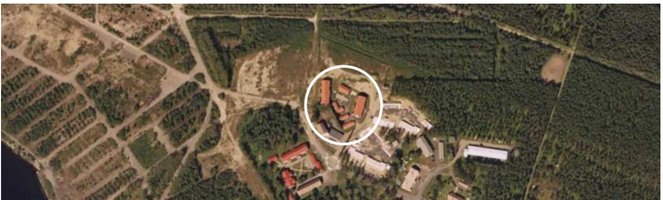
Kuva 16. Kukkaniti 2004. Viheralue on raivattu asuinrakennusten tieltä. Kuvat: Oulun kaupunki, ympäristö ja yhdyskuntapalvelut.
