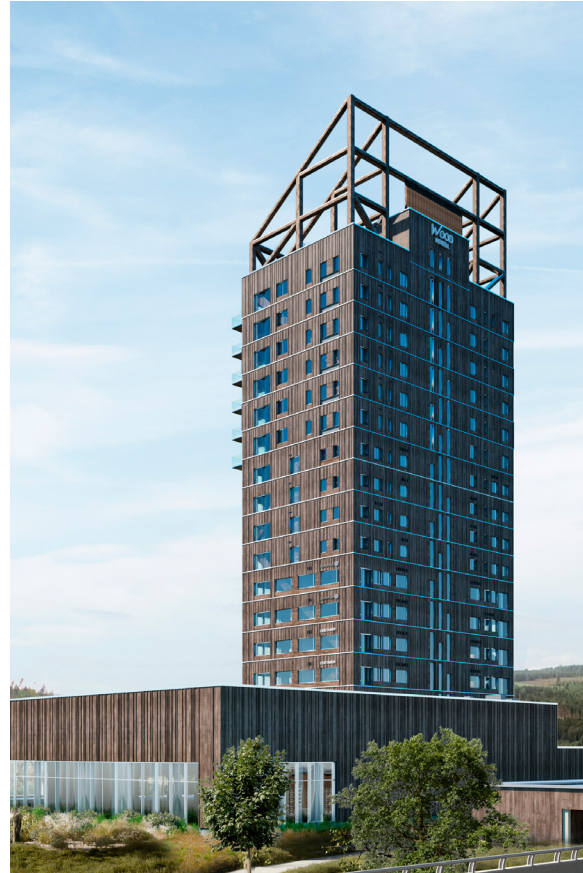
Kuva 62. Mjöstornet, Brumunddal, Norja
