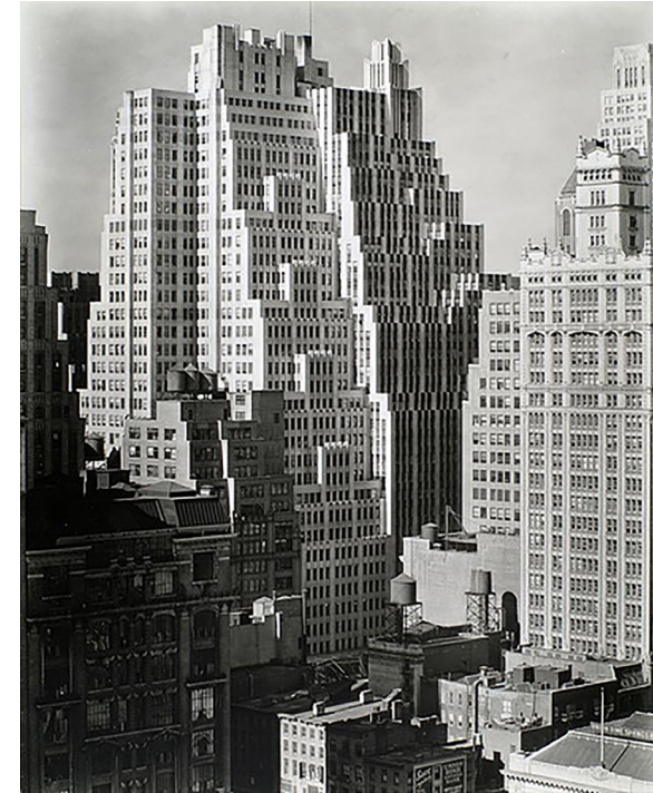
Kuva 4. keskikaupungista kohti 40th Street between Sixth and Seventh Avenues, rakennuksia, jotka ovat toteutuneet setback-määräyksen jälkeen. Rakennuksia luonnehdittiin puhekielellä hääkaururakennuksiksi.
