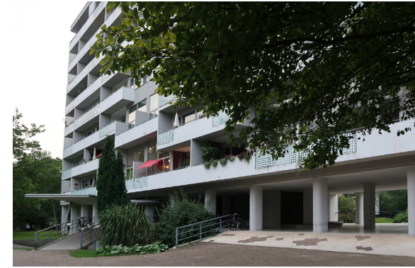
Kuva 51. Berliiniläisen asuintalon sisäänkäynti on suojattu lipalla. Rakennuksen läpi pääsee kulkemaan katetussa ulkotilassa.
