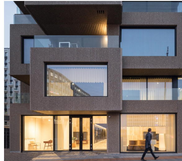
Kuva 50. Tukholman Norra Tornen juurella sisäänkäynnin ikkunat ulottuvat maahan asti. Ikkunat vahvistavat sisä- ja ulkotilojen yhteyttä.
