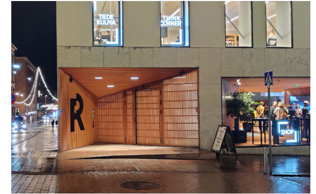
Kuva 52. Helsingin Tiedekulman sisäänkäynti erottuu myös pimeällä julkisivusta selkeästi läpikuultavan säleikön ansiosta.
