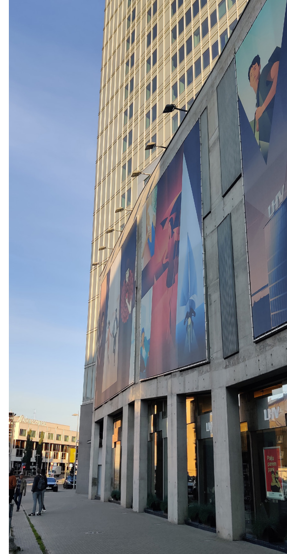
Kuva 48. Tallinnassa rakennuksen sisäänkäyntiä on korostettu selkeällä materiaalin muutoksella sekä jalustaan sijoitetun taiteen avulla.
