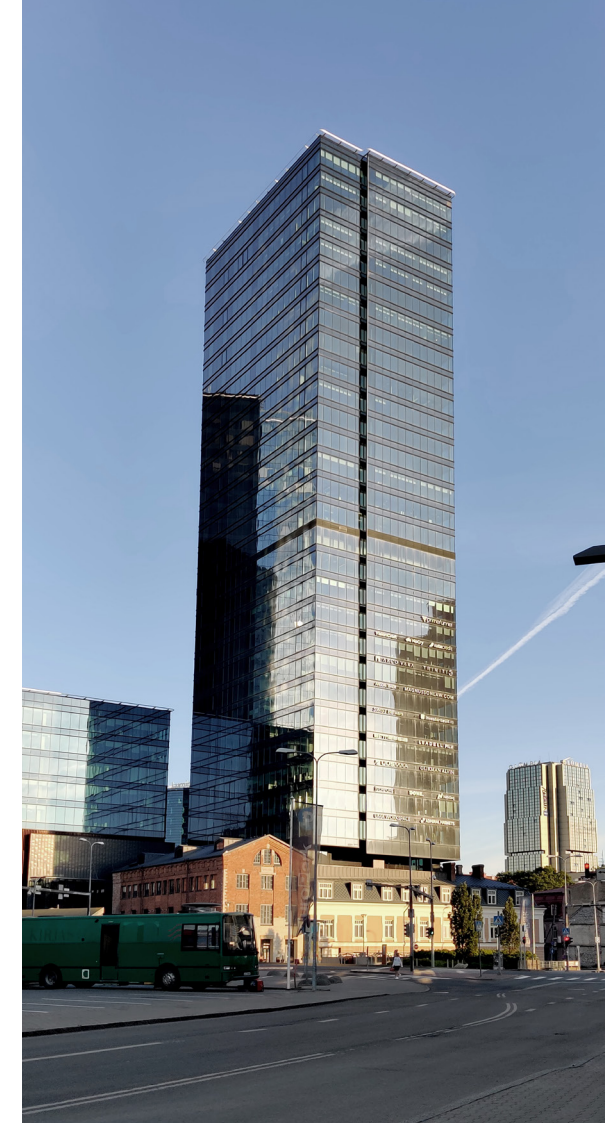
Kuva 49. Tallinna, lasinen tornitalo on tehty matalan rakennusten päälle. Erikoisen ratkaisun mahdollistaa sen, että katutila jatkuu samanlaisena kuin muu ympäristö.
