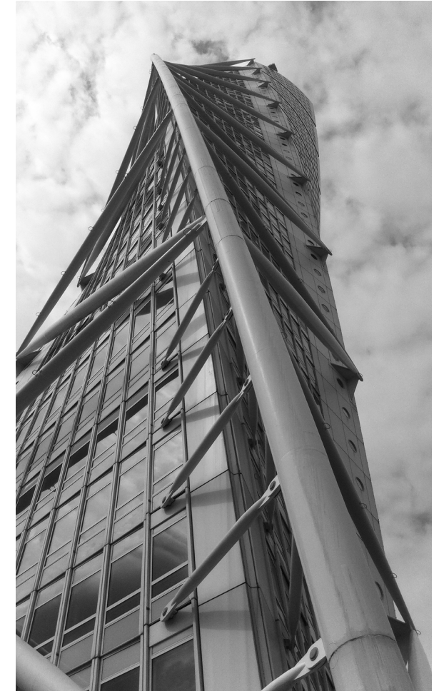
Kuva 16. Västra hamnen, Hamnen, Malmö, Sweden
