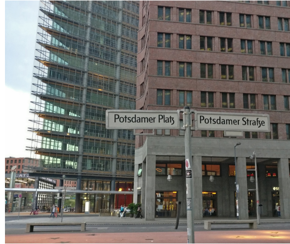
Kuva 47. Berliinin Potsdamer Platzilla rakennuksen jalusta erottuu muusta rakennuksesta värin ja materiaalin avulla. Kadulle on tehty sateensuojana toimiva katos.
