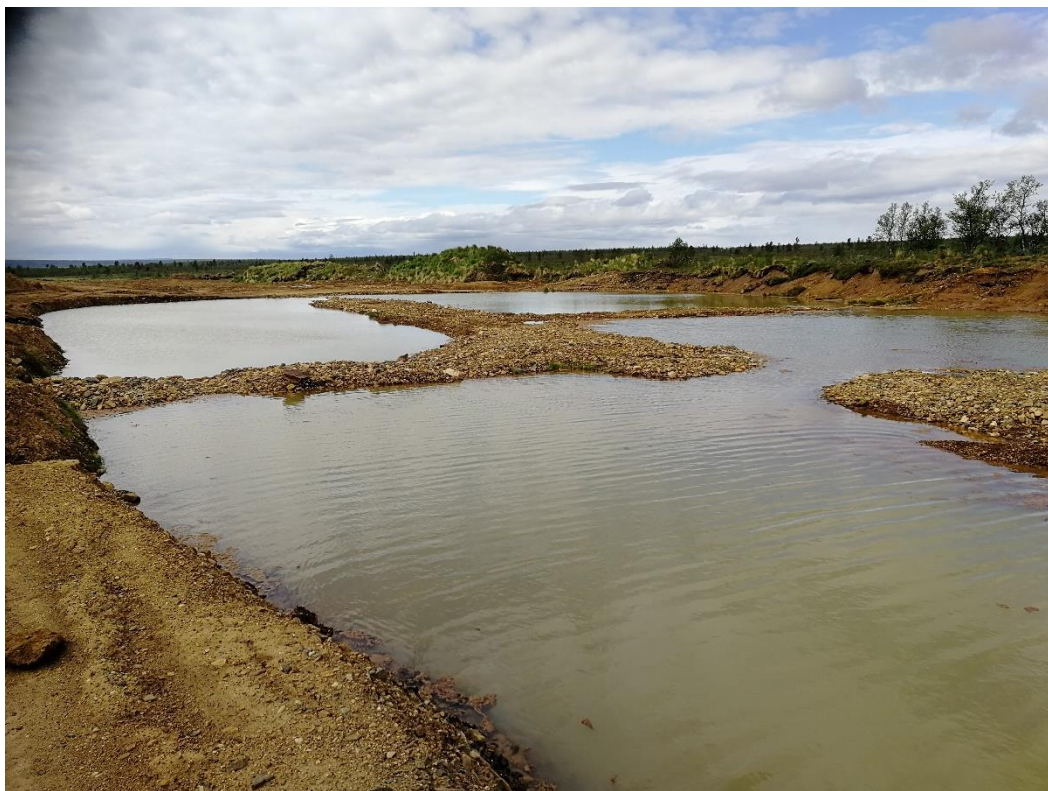
Kuva 5. Kullanhuuhdonnassa käytettäviä kierto-vesialtaita ja puoliläpäisevän maapadon erottamia laskeutusaltaita.
