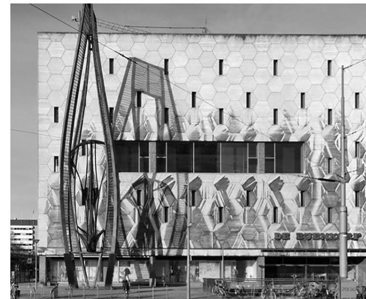
Kuva 31 (De Bijenkorf) ja 32. (Rotterdam Bouwt) Rotterdamin vilkkaassa risteyksessä sijaitsevan Bijenkorfin tavaratalon julkisivu muodostuu mehiläiskennomaisista travertiinilaatoista. Pakokaasut maalasi "sik-sak"-tyylinen tummanpuhuvan liukuvärin, mikä oli osittain Breuerin tarkoitus.
