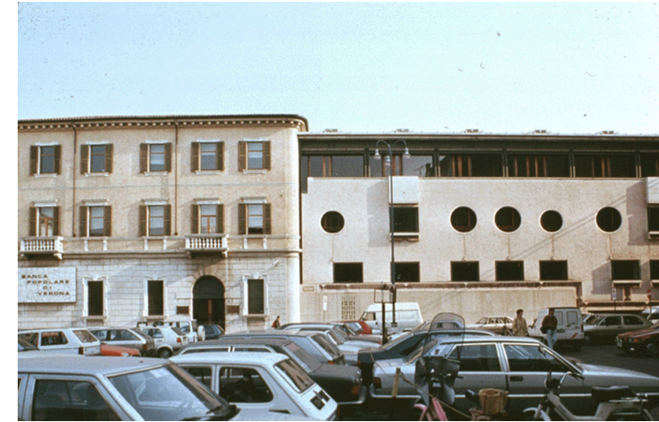
Kuva 26. Scarpan suunnittelema kansallispankki kuvassa oikealla. Kaksoisjulkisivun pyöreiden aukkojen vertikaalit sadevesilistat näyttävät kauempaa valumajäljeltä. (Kuvaaja Speck, L.)
