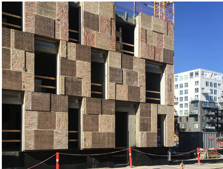
Kuva 10. Lendager Groupin ja Arkiteman suunnittelema Resource Rows-asuinkortteli rakenteilla vuonna 2018 Kööpenhaminassa. Julkisivuelementtien tiilet on kierrätetty purettujen rakennusten julkisivuista. (Kuvaaja: Seier, J. K. 2018)
