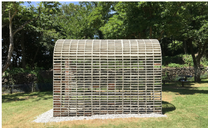
Kuva 21. STPMJ:n liukeneva tiiliholvi on muurattu suolatiilistä, jotka ovat lienneet sadeveden vaikutuksesta jättäen jälkeen raudoitettun laastirangan. (Archdaily)
