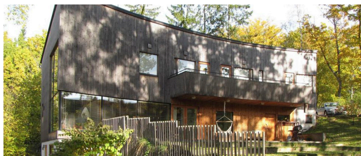
Kuva 19 (Sanaksenaho Architects 2001) ja 20 (Sanaksenaho, P. 2017). Sanaksenaho arkkitehtien suunnittelema Talo Tammimäki valmistui vuonna 2001 Espooseen. Puiden ulkoverhous on harmaantunut paljaammilta osiltaan nopeammin kuin suojaosan parvekkeen alta. Lämmin sävy harmaantunutta puujulkisivua vasten antaa tyylikkään lisän rakennuksen julkisivulle.
