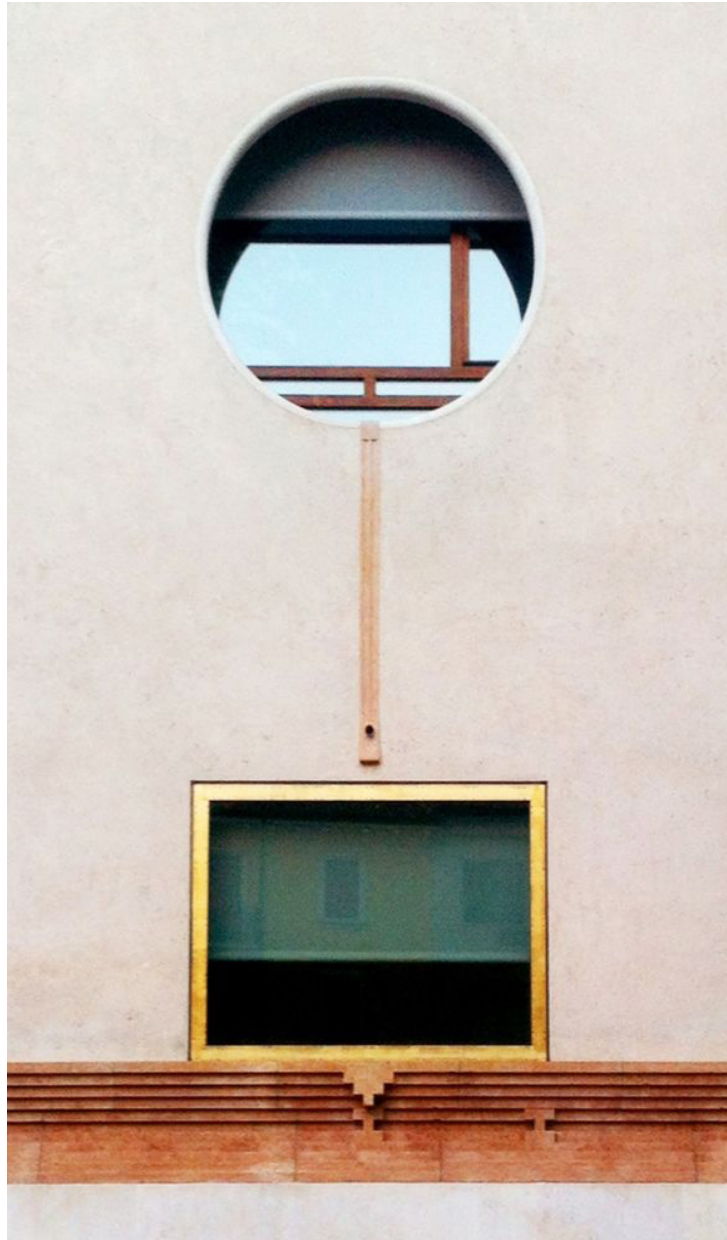
Kuva 27. Veronan kansallispankin kaksoisjulkisivun detaljit on suunniteltu tarkoin varjelemaan rapattua julkisivua. Sadevesilista on sijoitettu valumajäljen kohdalle. (Dearart 2019)
