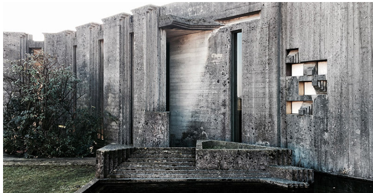
Kuva 28, 29, 30. Venetsiassa sijaitseva Brionien hautapyhättö on tilasarja puutarhassa. Scarpa on tarkoituksella valinnut kauniisti patinoituvia materiaaleja, jotta paikka muuttuisi kauniimmaksi ajan myötä. (Architectours 2016)
