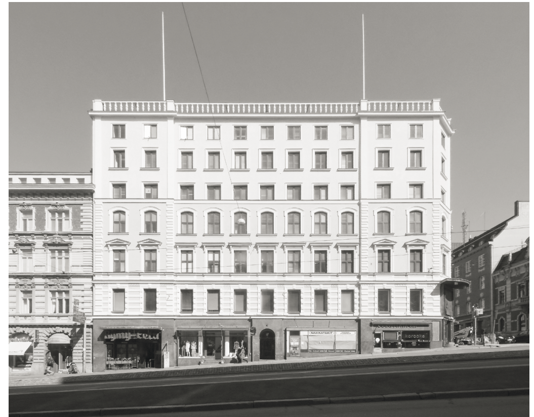
12 Erottajankatu 15-17. Valmistui uusrenessanssin aikaan 1886, mutta on kokenut korotuksen kahdesti. Ensimmäinen korotus tapahtui vuonna 1920, uusklassisismiaikaan. 1950-luvulla rakentunut korotusosa pyrki tyyliään erottamaan olemassa olevasta osasta. (Ilonen 2013: 77, Arska-palvelu 2019.)
