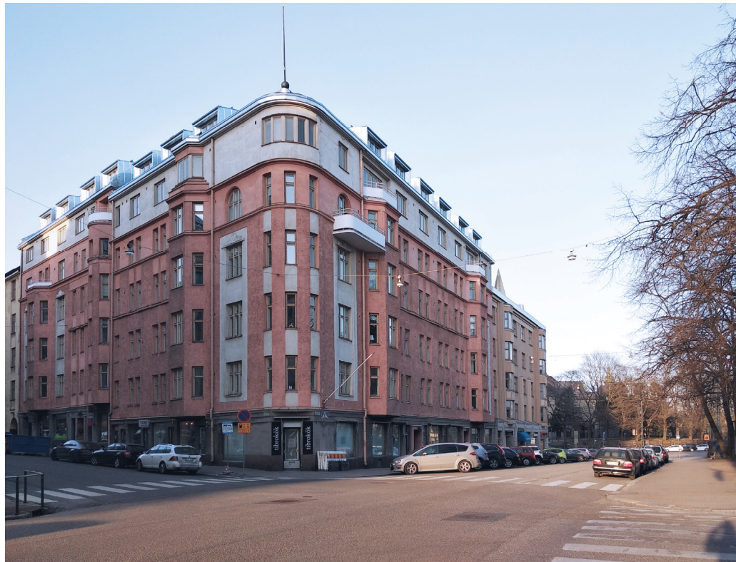
13 Osoitteessa Museokatu 5 Etu-Töölössä sijaitseva rakennus suunniteltiin vuonna 1911 viisikerroksiseksi, mutta siihen suunniteltiin kuudes kerros funktionalismin vaikuttaessa vuonna 1935. Lupa on vahvistettu vuonna 1986. Samalla katutasan aukkoja kasvatettiin. Vuonna 2014 rakennukseen suunniteltiin asuinulakko. Rakennus oli huputettuna vielä vuonna 2018. (Piirustus ja tiedot ARSKA-palvelu.)
