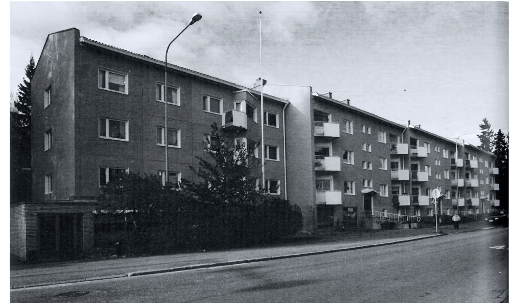
28 Maunulan Metsäpurontie 18–20 suunnitteli Veikko Larkas vuosina 1953–1954. Vinot parvekkeet elävöittävät julkisivua. (Salastie ym. 2007: 100 via Heikinheimo 2005)
