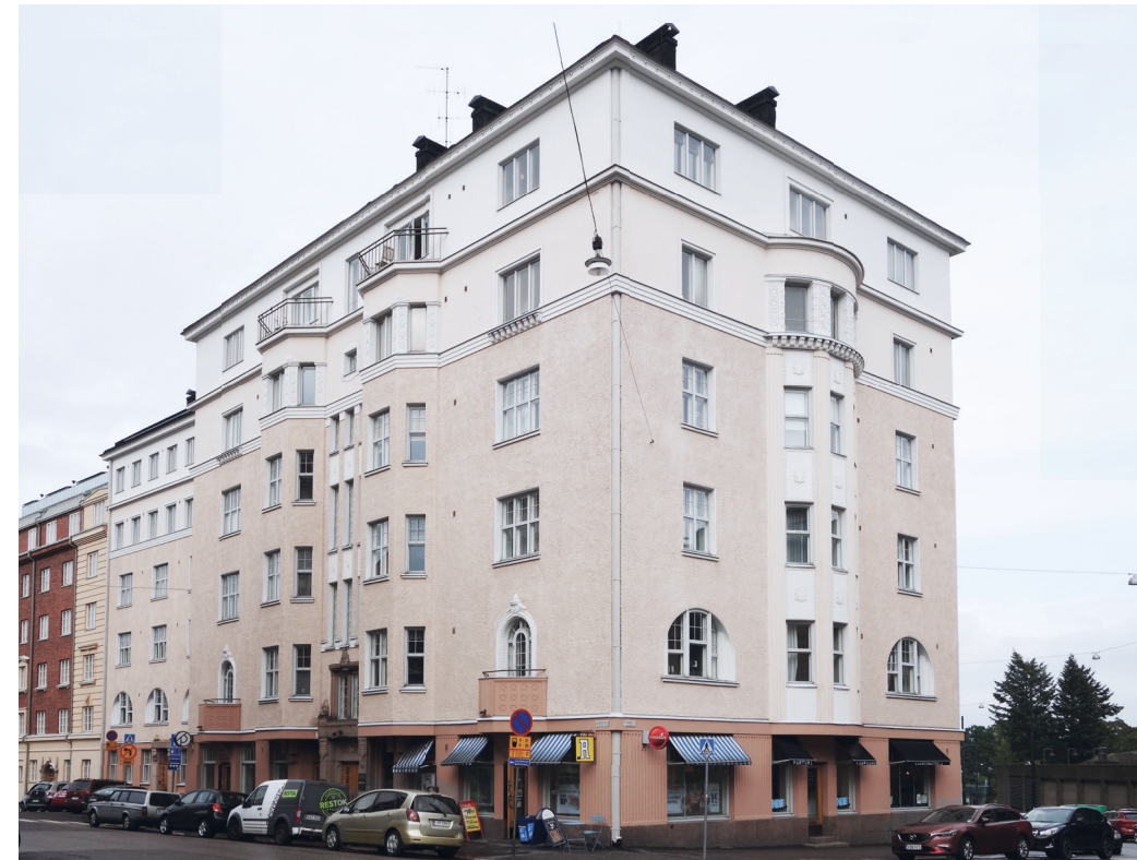
14 Helsingin kaupunginosista muun muassa Etu-Töölössä rakennuksia on korotettu aikojen kuluessa. Rakennusta osoitteessa Nervanderinkatu 5 (1912) ei ole ilmeistä huolimatta korotettu 2000-luvulla, vaan kuudennen kerroksen lupa on vahvistettu jo vuonna 1933. (Piirustus ja tiedot ARSKA-palvelu.)
