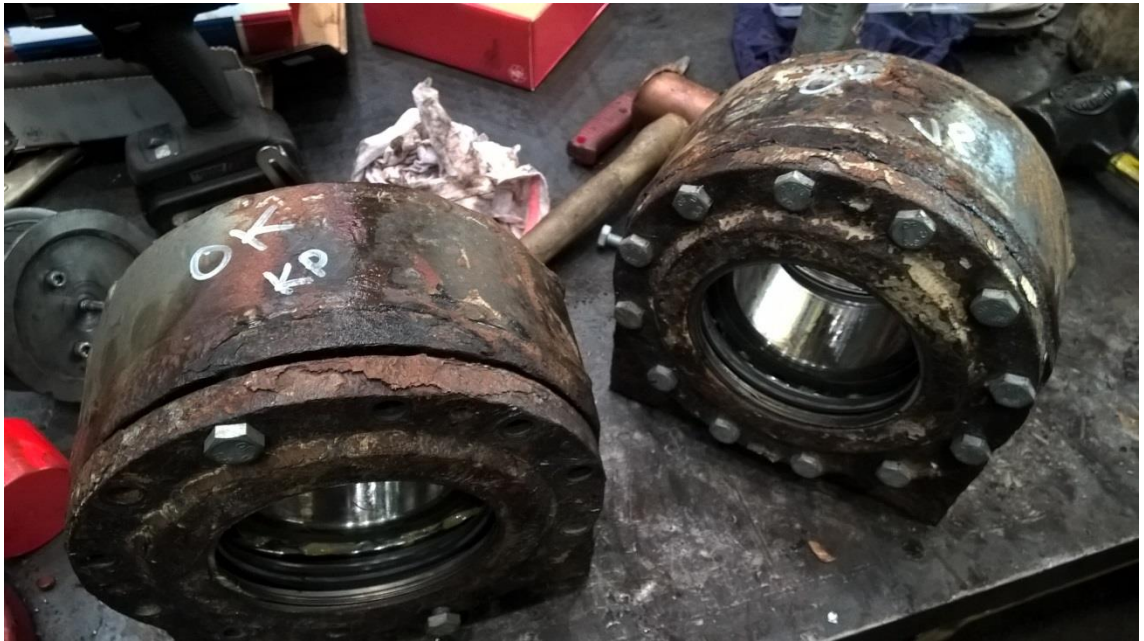
Kuva 37. "OK"=huollettu ja "KP"=koeponnistettu
