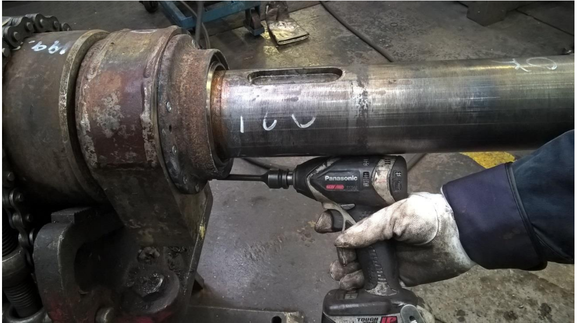
Kuva 71. Lopuksi vielä laakeripesän kansi paikoilleen. Pesä myös rasvataan tässä vaiheessa.
