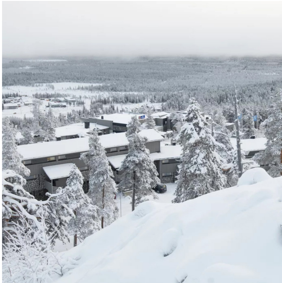
Kuva 22: Rakennukset uppoavat tunturimaisemaan.
