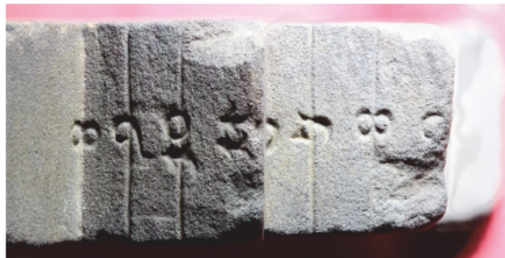
Kuva 29. Numerointia sakaroiden sisäkulmissa. Vasemmalla on sakaran 4 b-sivun numerointi 8–11. Numero kahdeksan sisäkulmassa. Kuva Susanna Kuokkanen
