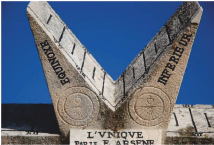
Kuva 19. Anecyn seitsemäsakarainen kello, takaosan talvi ja syyskellot. Kellojen gnomonit näyttävät puuttuvan. Kuva luvalla Cadrans solaires originaux- www.cadrans-solaires.fr .
