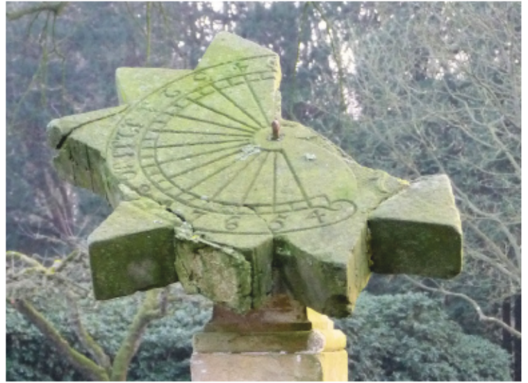
Kuva 81. Echten Manorin tähtikello ennen restauraatiota. Huom. 1) Kello on joutunut väärään asentoon. 2) Numeron viisi kohdalla sisäkulmassa numero 2. Sama kello restauroituna kuvassa 79. Kuva Frans Maes.
