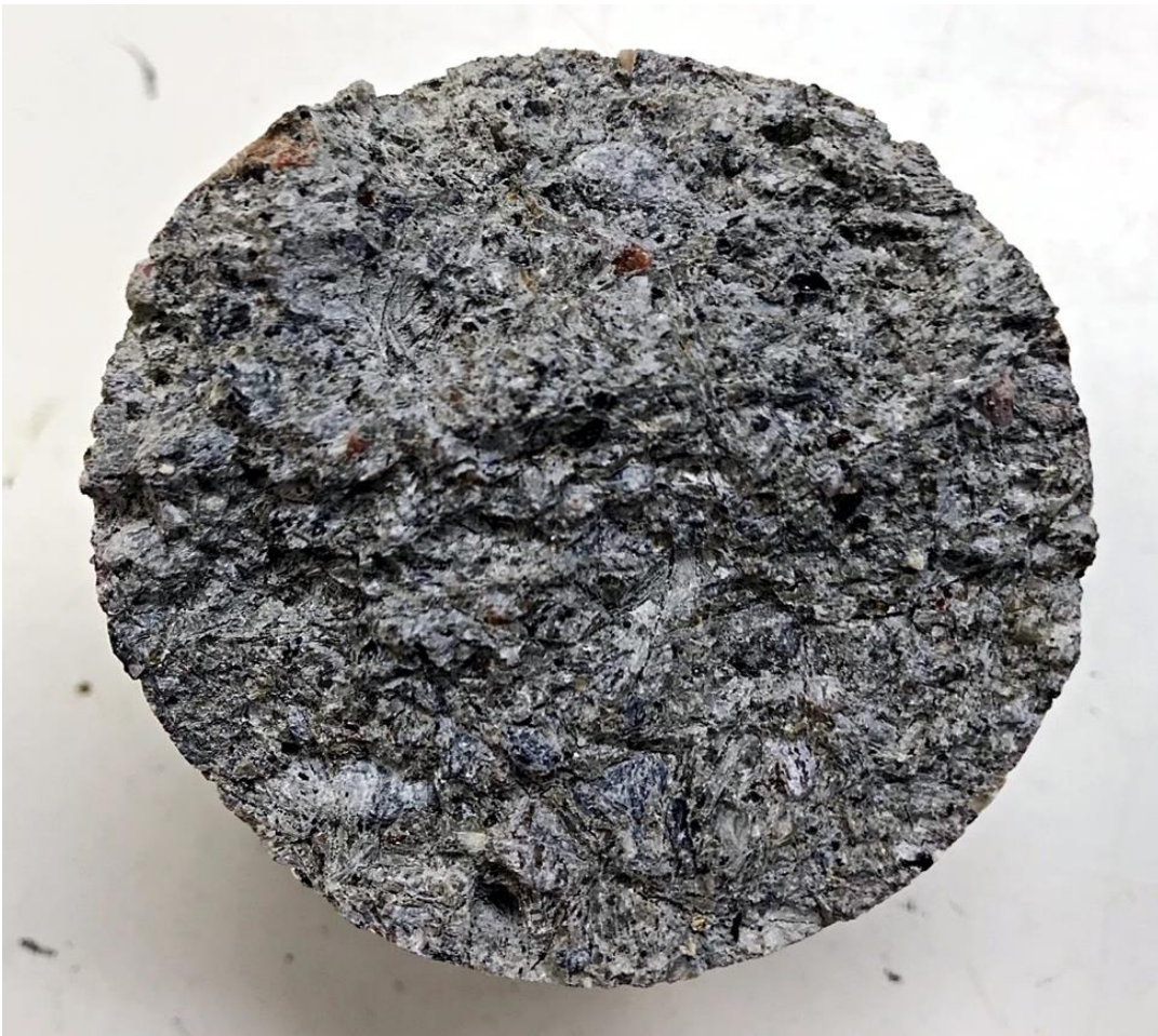
Kuva 17. Tuoreen betonin jääytymisestä johtuvaa neulasmaista rakennetta. Kuva vetolujuuskappaleen murtopinnassa. Lieriön halkaisija on 50 mm. (Kuva Antti Autere)
