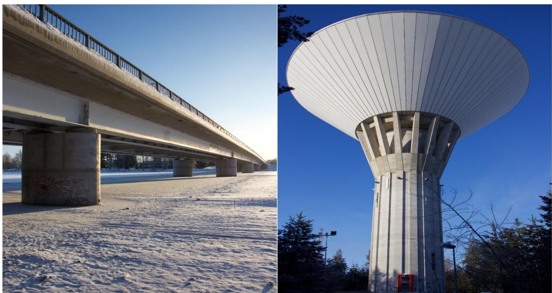
Kuva 2. Betonia käytetään monenlaisissa infrarakentamisen kohteissa. (Kuvat Antti Autere)
