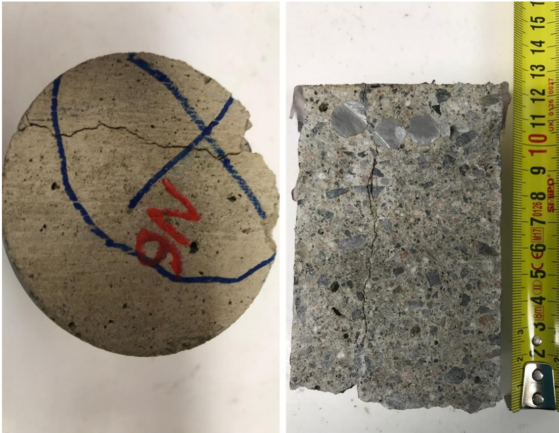
Kuva 18. Voimakas pintaa vastaan kohtisuora halkeama nuoressa betonissa. Halkeama kulkee lähellä pintaa olevien terästen välistä. Vasemmalla olevassa kuvassa halkeama kuvattuna lattiavalun pinnasta. Oikeassa kuvassa sama lieriö halkaistuna, lattian pinta kuvassa ylhäällä. Näyte on porattu lattiavalusta. (Kuva Antti Autere)
