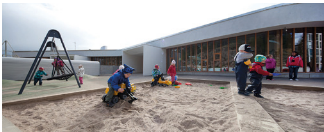
Kuva 34. Saunalahden lastentalo. Pihan hiekkalaatikot tuovat pihalle luonnonmukaisuutta ja suurina alueina mahdollistavat laadukkaatkin leikit.
