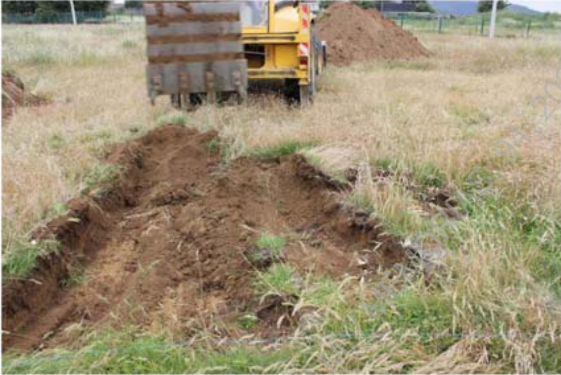
Foto 3 – Decapagem de terras na sondagem 1.
