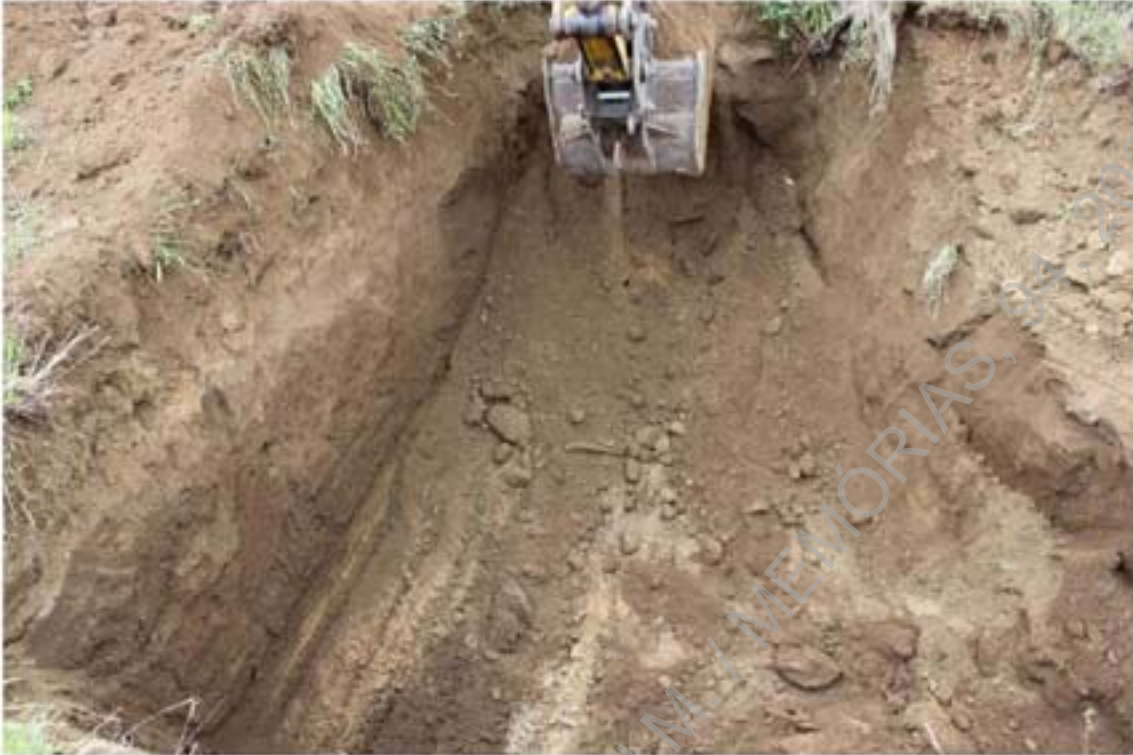
Foto 17 – Decapagem de terras na sondagem 3.
