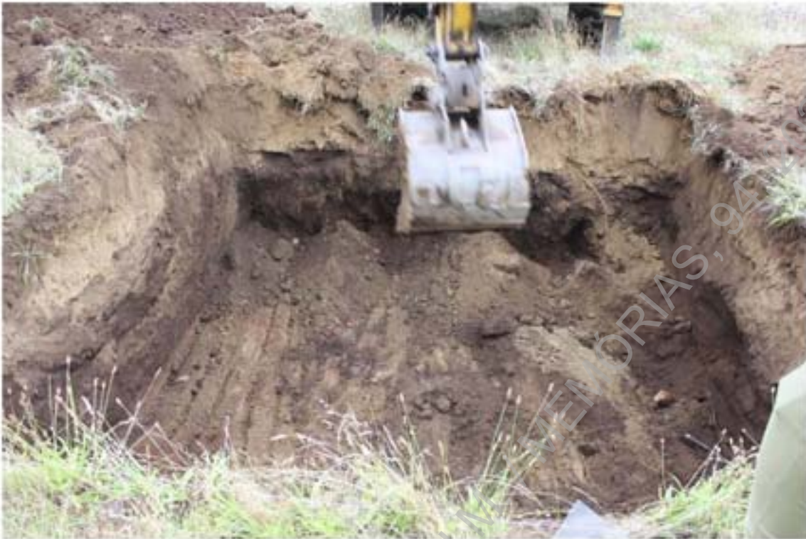
Foto 31 – Decapagem de terras na sondagem 5.
