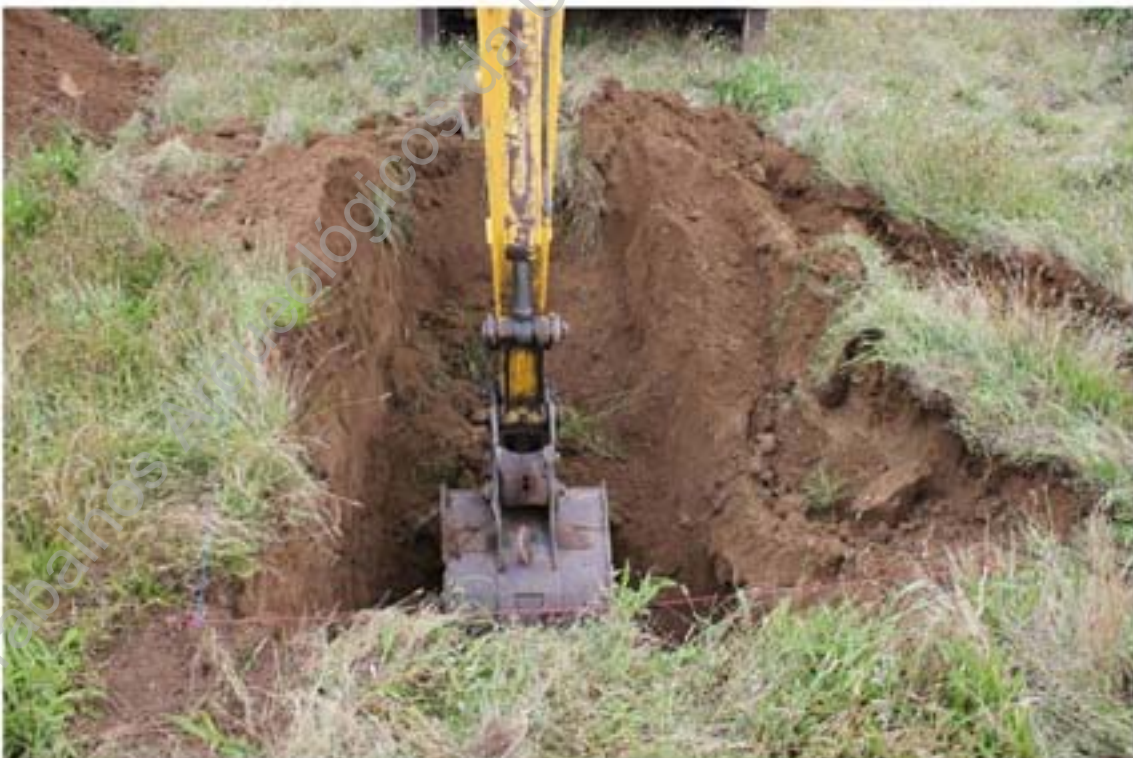
Foto 24 – Decapagem de terras na sondagem 4.
