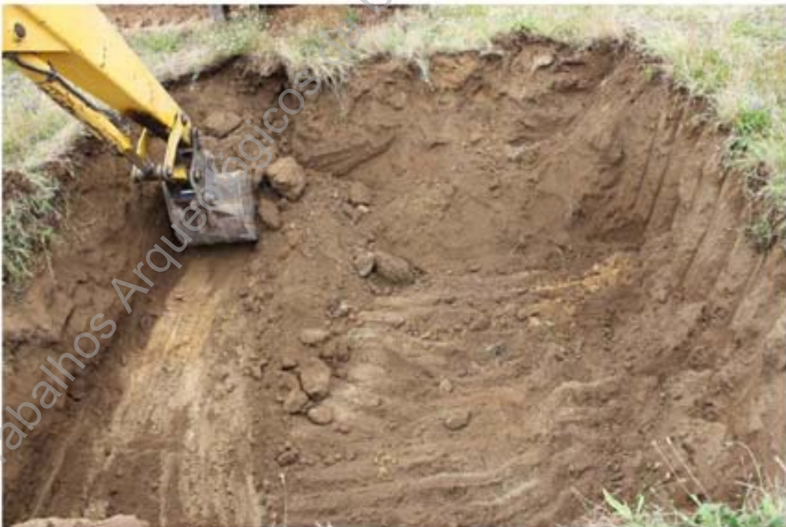
Foto 10 – Decapagem de terras na sondagem 2.
