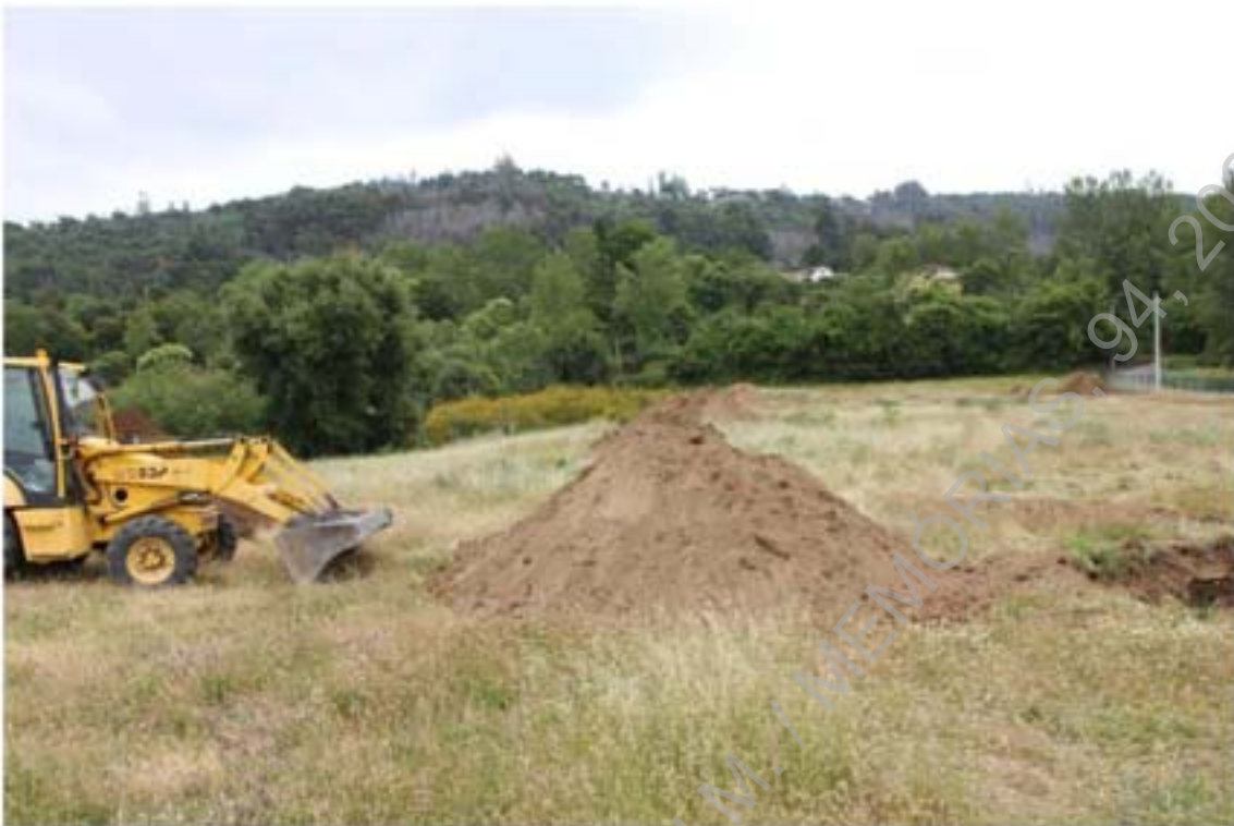
Foto 1 – Vista geral da área intervencionada.
