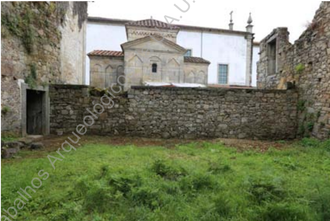
Foto 4 - (IMG_0660) - Aspeto de plataforma de mausoléu antes de intervenção.
