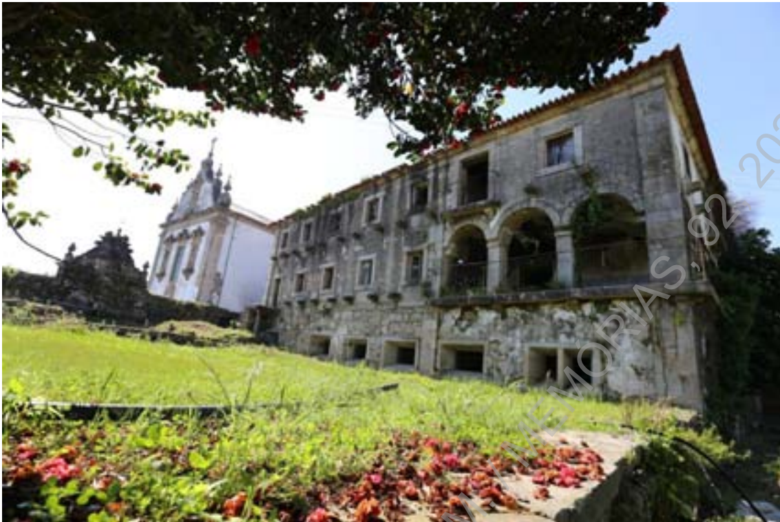
Foto 1 - (IMG_0361) - Aspeto geral do convento antes de intervenção (SE/NO).
