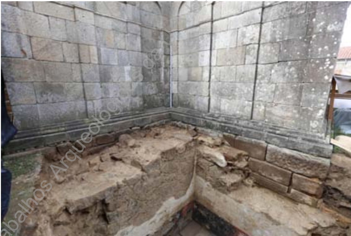
Foto 43 - (IMG_3296) – Alçado sul e este, sondagem 18.
