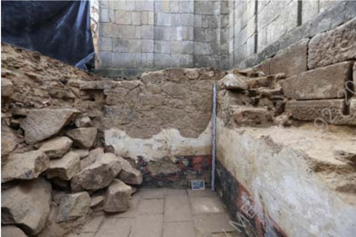
Foto 44 - (IMG_3282) – Alçado sul, sondagem 18.
