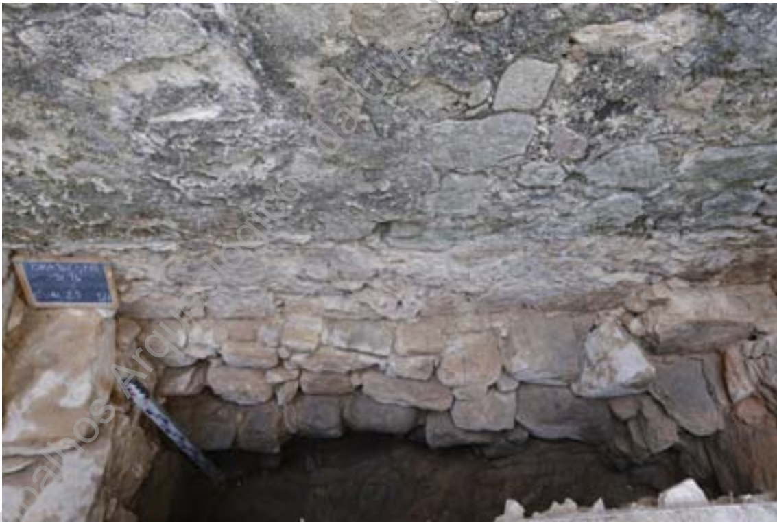
Foto 16 - (IMG_1033) – Pormenor de zona este de alçado 21, sondagem 14.
