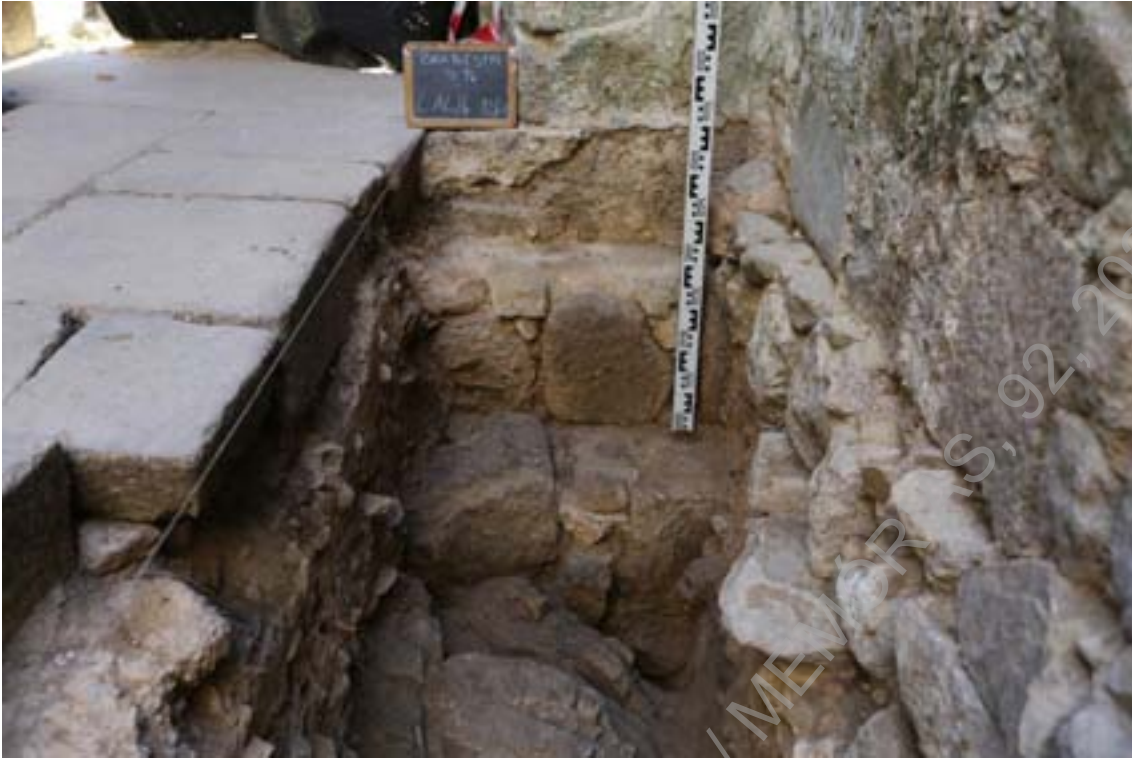
Foto 17 - (IMG_1024) – Pormenor de alçado 24, sondagem 14.
