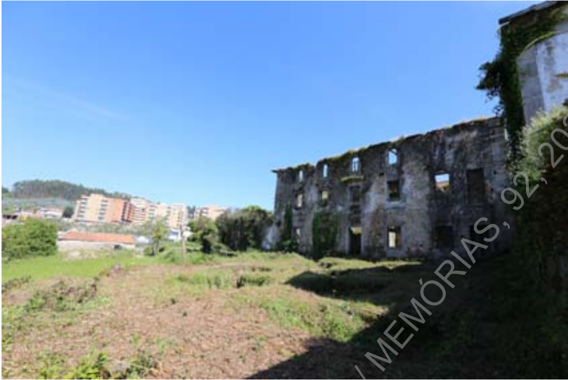
Foto 3 - (IMG_0381) - Aspeto geral do convento antes de intervenção (NO/SE).
