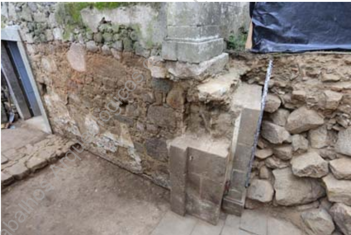
Foto 45 - (IMG_3290) – Alçado norte, sondagem 18.
