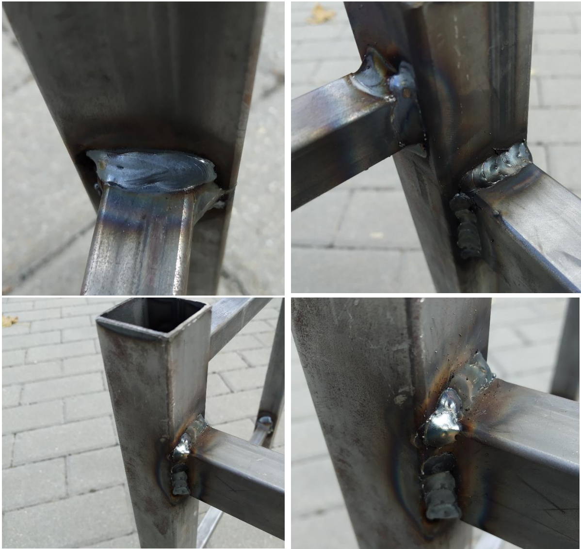
Figura 2-19. Fotografías de algunas de las soldaduras de la estructura.
