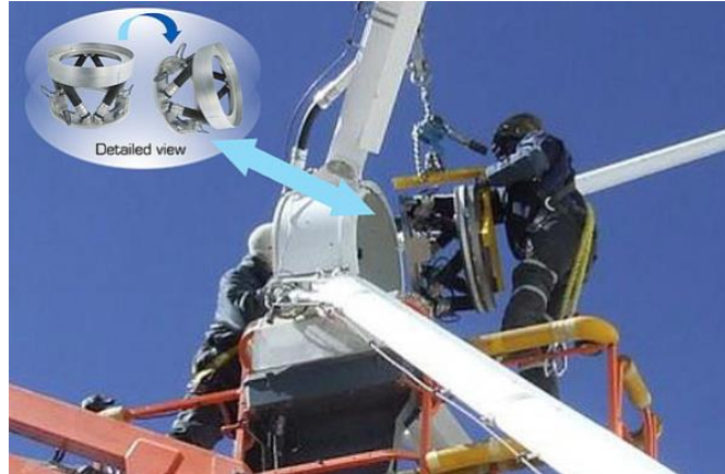
Figura 29 Instalación de hexápodo como sistema de alineación en telescopio ALMA.
