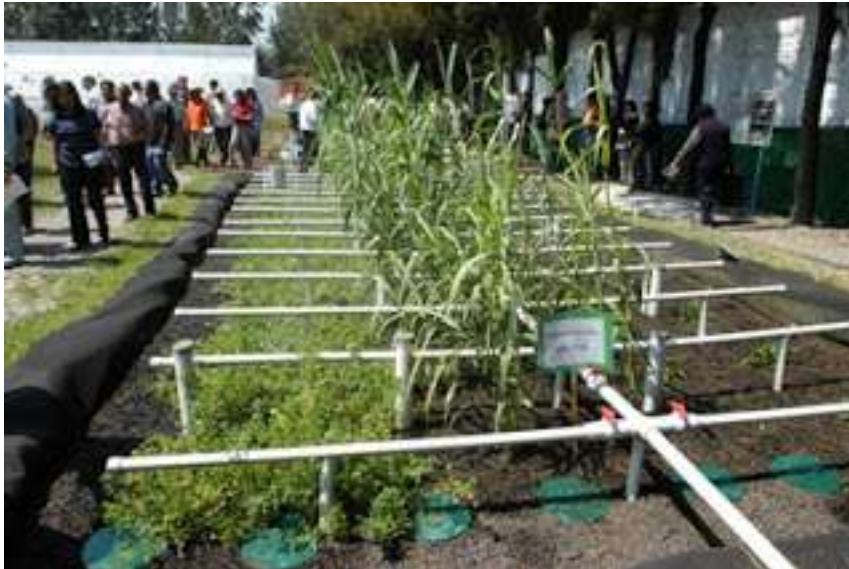
Figura 6. Planta Piloto tipo Humedal Artificial de Flujo Combinado UNAM- UAM-X. Fuente: http://sabersinfin.blogspot.com/2007/10/inauguraron-hoy-unam-y-uam-x-una-planta.html
