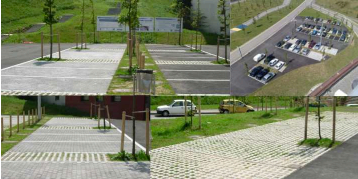
Figura 4. Estacionamiento experimental “Las Llamas” en Santander, España, donde se estudia la permeabilidad de distintos tipos de pavimentos porosos. Fuente: Dr. Jorge Rodríguez Hernández. Grupo de Investigación de Tecnología de la Construcción (GITECO) de la Universidad de Cantabria.
