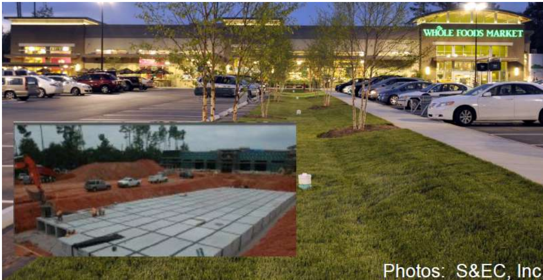
Figura 3. Ejemplo de una instalación para captación de agua de lluvia en el estacionamiento de un supermercado en los Estados Unidos. Fuente: Annette Lucas. Departamento de Calidad Ambiental de Carolina del Norte.
