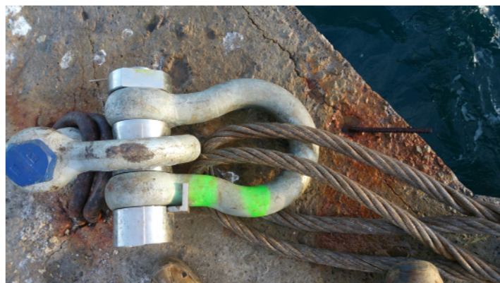
Fig. 5. Grillete monitorizado instalado en las líneas de amarre al cajón anterior.
