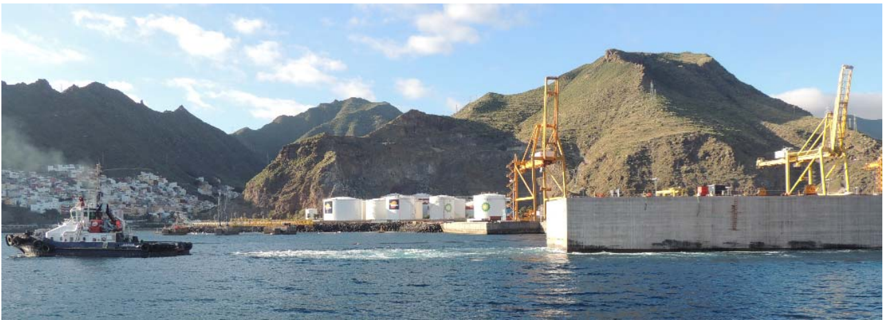
Fig. 7. Cajón remolcado a la salida del Puerto de Granadilla
