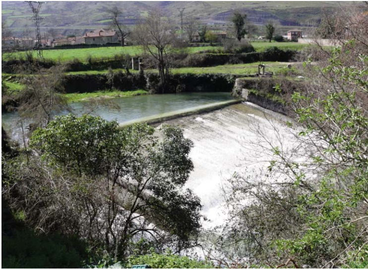
Figura 8. Azud para la fábrica de harinas La Inesuca. Santa Cruz de Iguña. Colección del autor, 2016.
