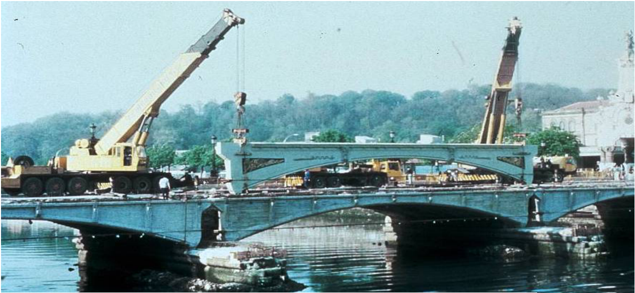
Figura 33: Izado y colocación de Arcos-Tímpano.
