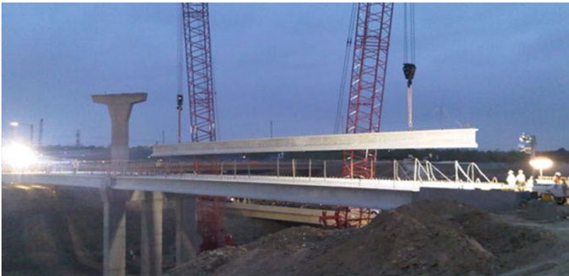
Figura 42: Izado de vigas prefabricadas tipo T.
