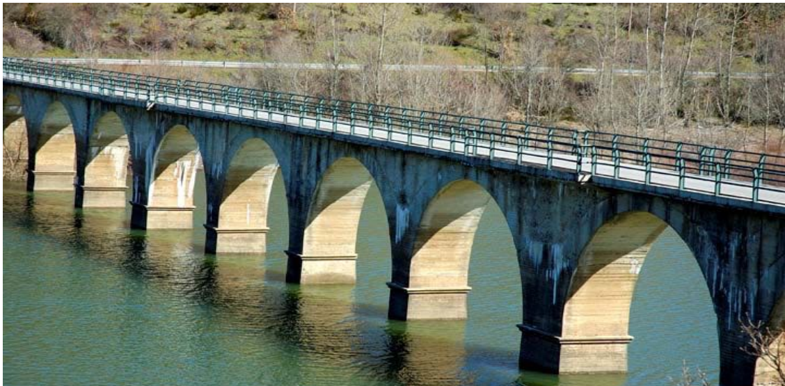
Figura 15: Vista del puente actual, una vez reforzado y mejorado. [11] (Palencia).
