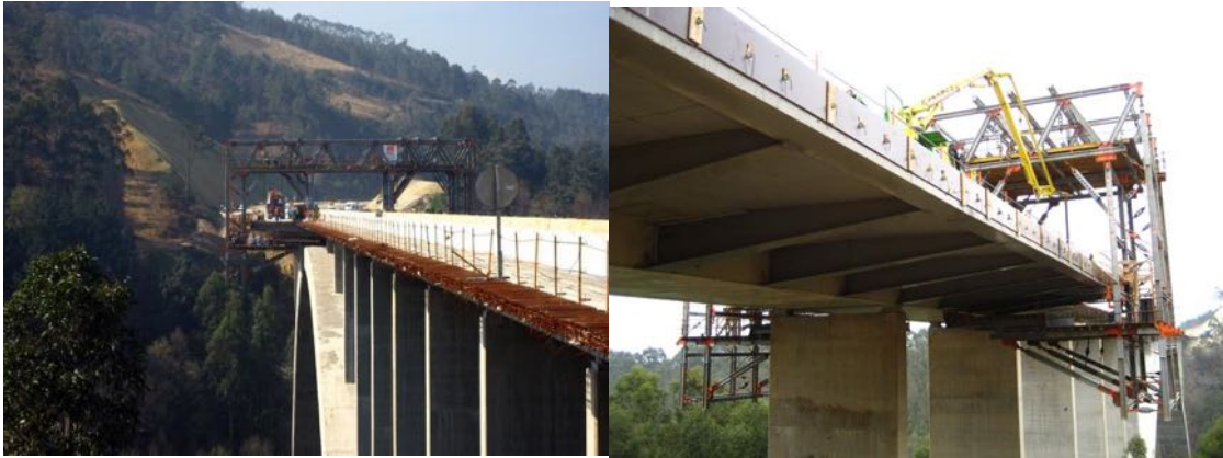
Figura 55: Carro para la colocación de la estructura metálica y el hormigonado de la losa.
