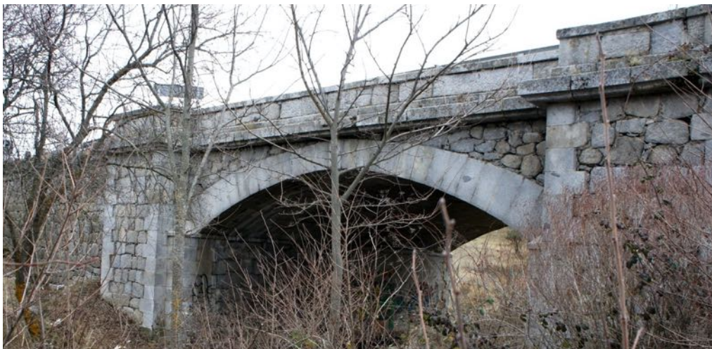
Figura 17: Vista general del puente, N-110 (PK-202.5)
