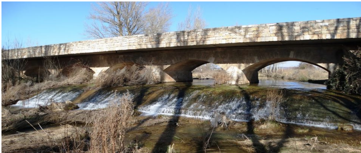
Figura 25: Puente aguas abajo una vez realizada la ampliación. [12]
