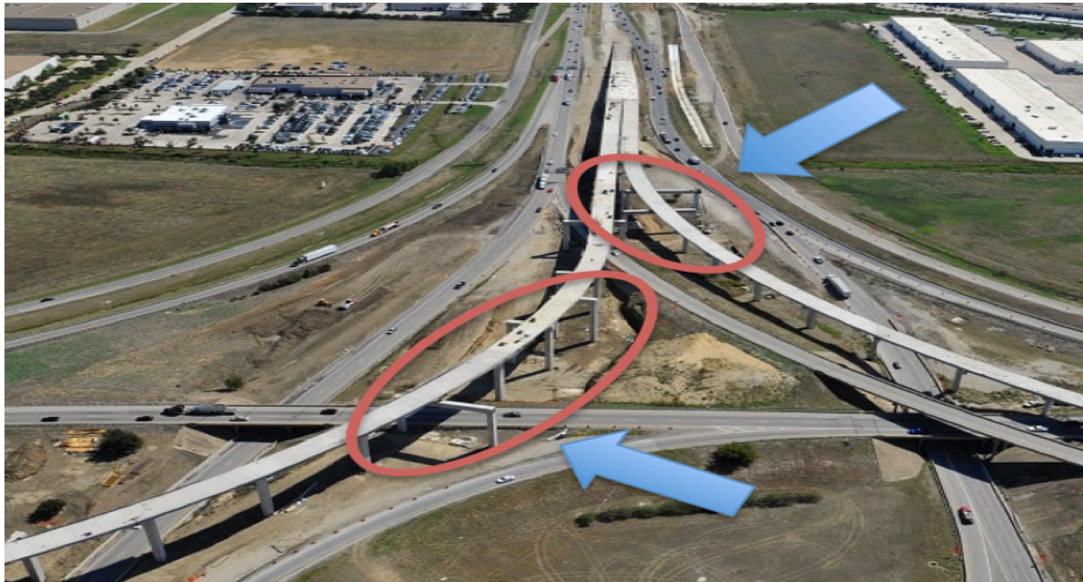
Figura 40: Vista general de un tramo de autopista con estructuras previstas para una futura ampliación
