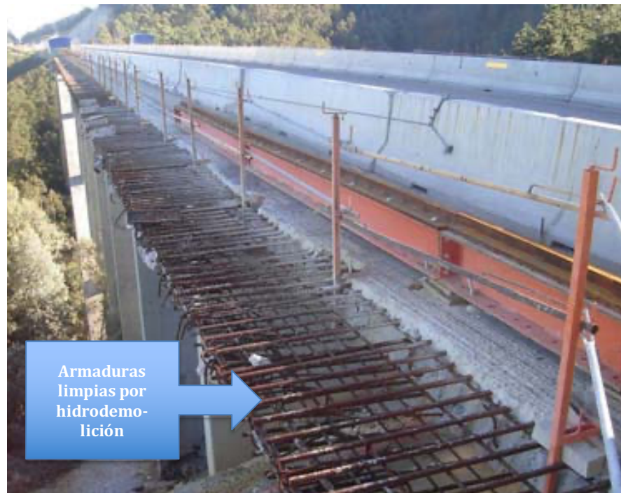
Figura 54: Hidrodemolición de parte del tablero.
