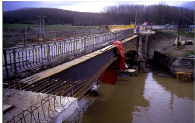
Figura 37: Colocación de la viga metálica lateral. [18]
