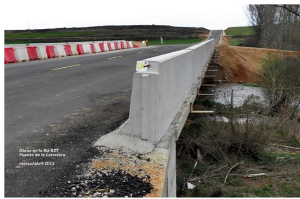
Figura 24b: construcción de barrera lateral y revestimiento de esta. [12]
