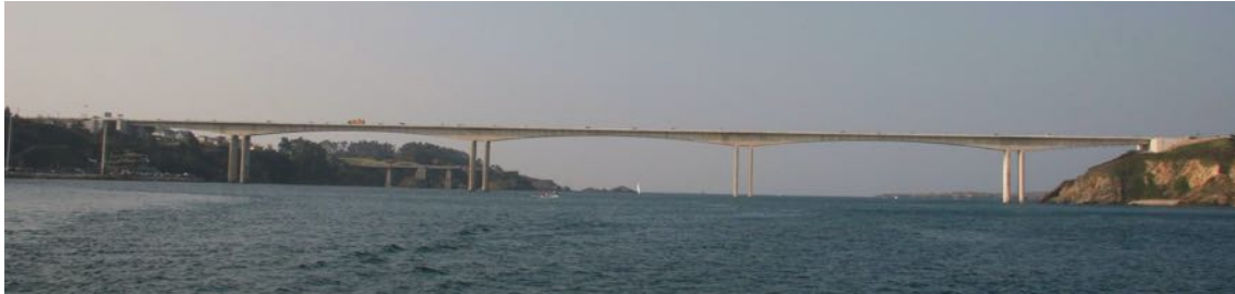
Figura 59: Vista general del Puente de Los Santos sobre la Ría del Eo.
