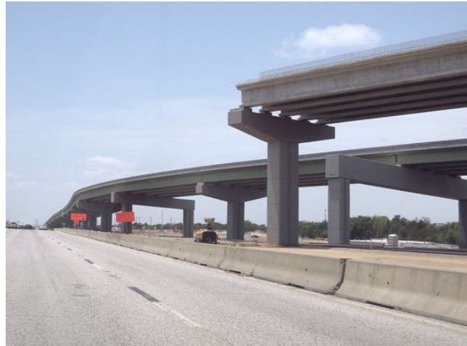
Figura 43: Vista general de distintos tipos de pila (circular y rectangular).
