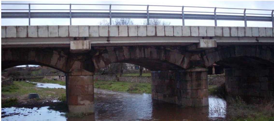
Figura 20: Vista general del puente sobre el Froya, tras la realización de la ampliación.
