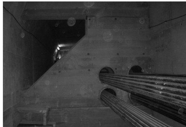
Figura 73: Pretensado exterior entre diafragmas.
