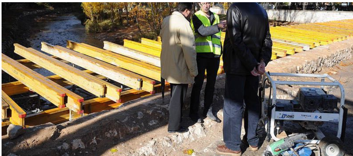
Figura 26: Colocación de elementos auxiliares y encofrados en los voladizos laterales.
