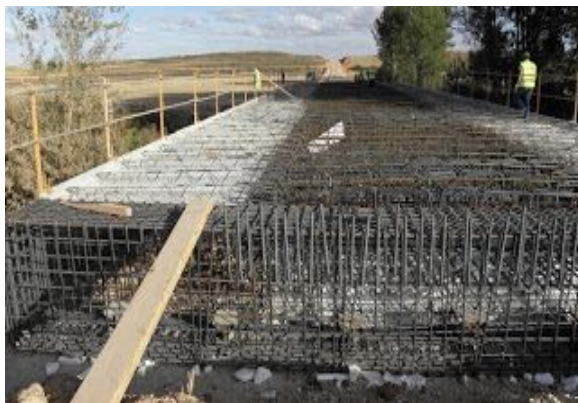
Figura 24a: Colocación del acero de refuerzo en el tablero. [12]
