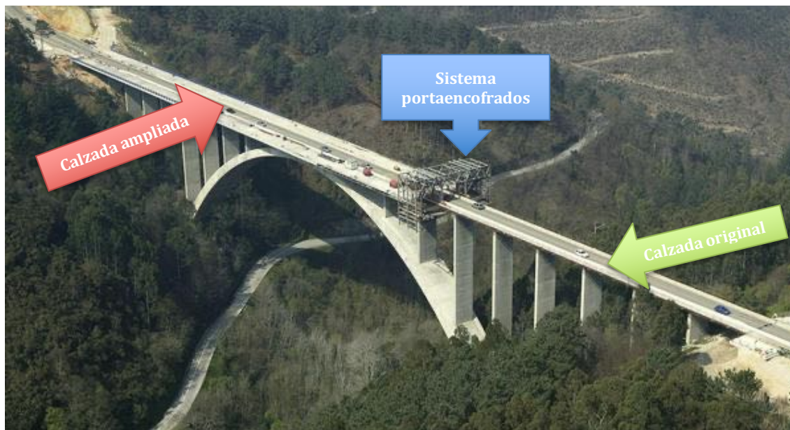
Figura 56: Vista general calzada ampliada vs calzada original.
