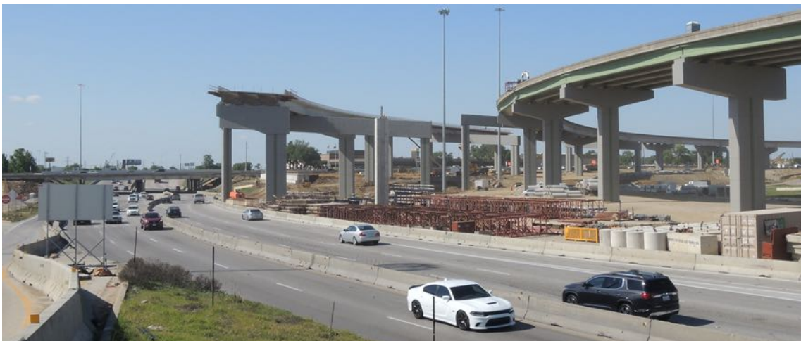
Figura 42: Vista general de ampliación autopista SH-183.
