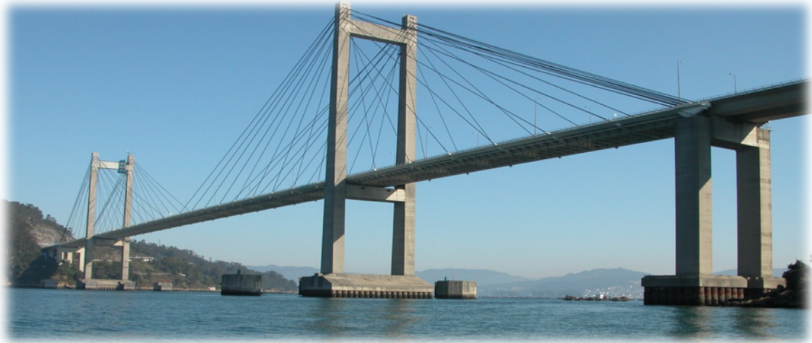
Figura 77: Vista general del Puente de Rande (AP-9) antes de acometerse la ampliación.
