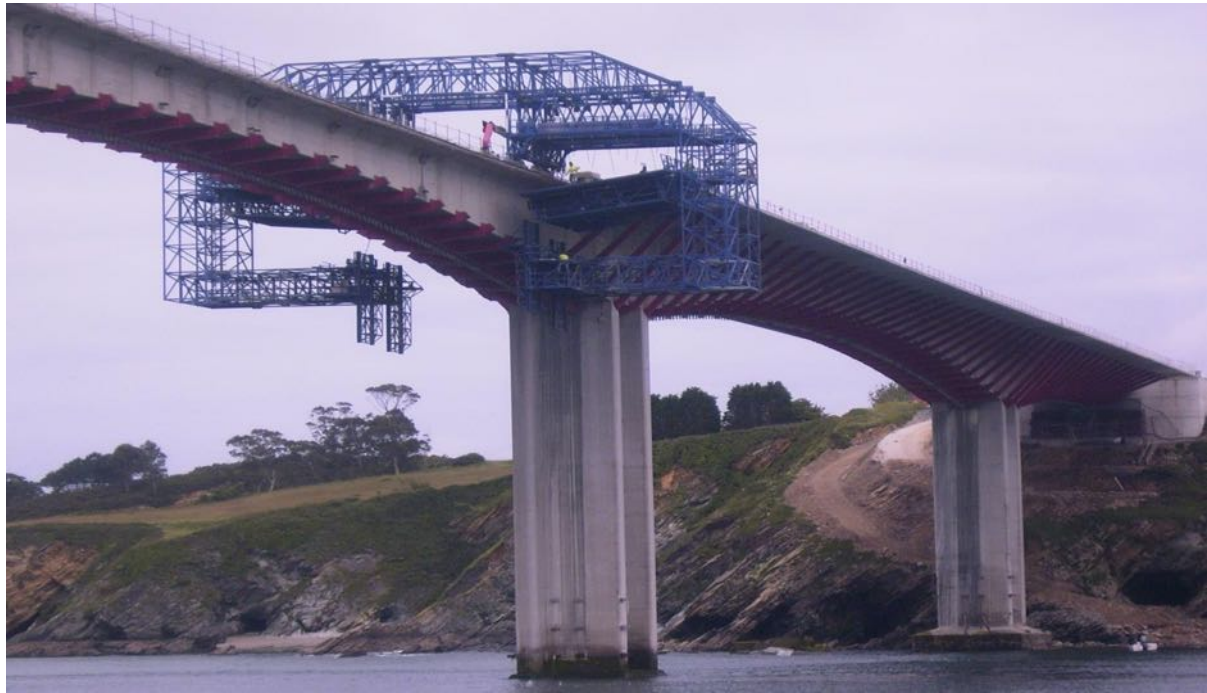
Figura 72: Vista real de la estructura móvil para la colocación de jabalcones metálicos y hormigonado de la losa superior del tablero.
