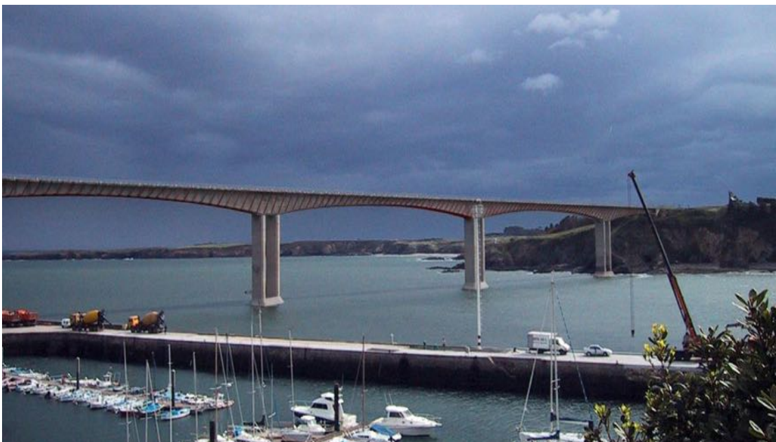
Figura 76: Vista general del puente una vez finalizada la ampliación (se observa el recrecido en la cimentación y la estructura metálica con los nuevos jalcones).
