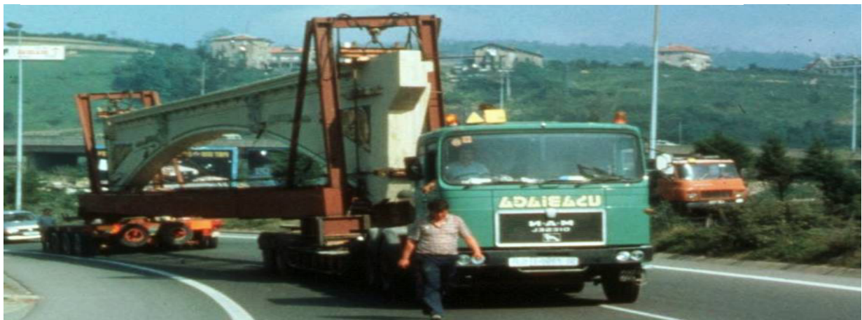
Figura 32: Transporte de Arcos-Tímpano.
