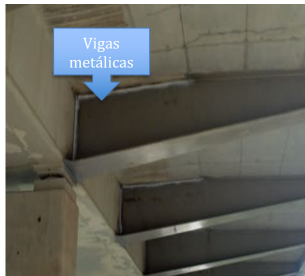
Figura 53: Detalle de voladizos de vigas metálicas soldadas al cajón.
