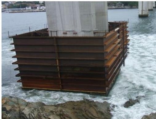
Figura 65: Recinto metálico estanco para desarrollar los trabajos de recrecido de la cimentación.
