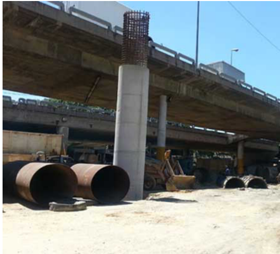
Figura 43: Vista general de distintos tipos de pila (circular y rectangular).
