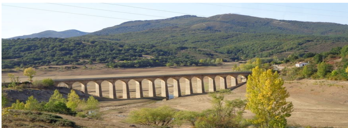
Figura 14: Vista general del puente, anterior a la ampliación.
