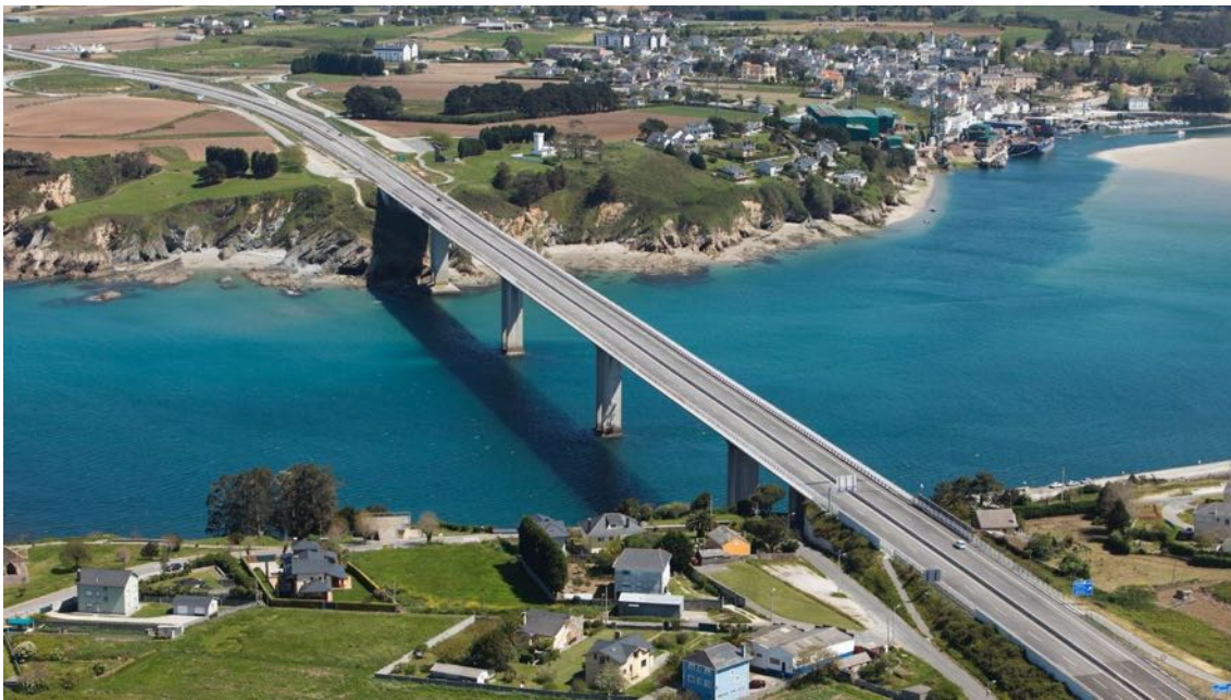
Figura 75: Vista de la calzada ampliada del puente a 2+2 carriles.
