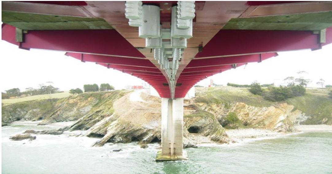
Figura 69: Vista inferior del cajón, detalles de la unión de la estructura metálica al cajón de hormigón original con ayuda de una tercera alma.
