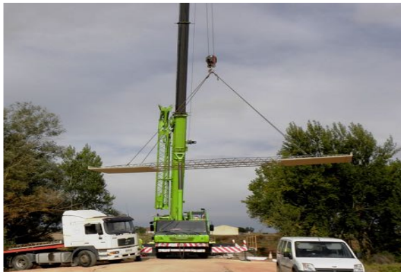
Figura 22: Izado y colocación de las losas prefabricadas. [12]
