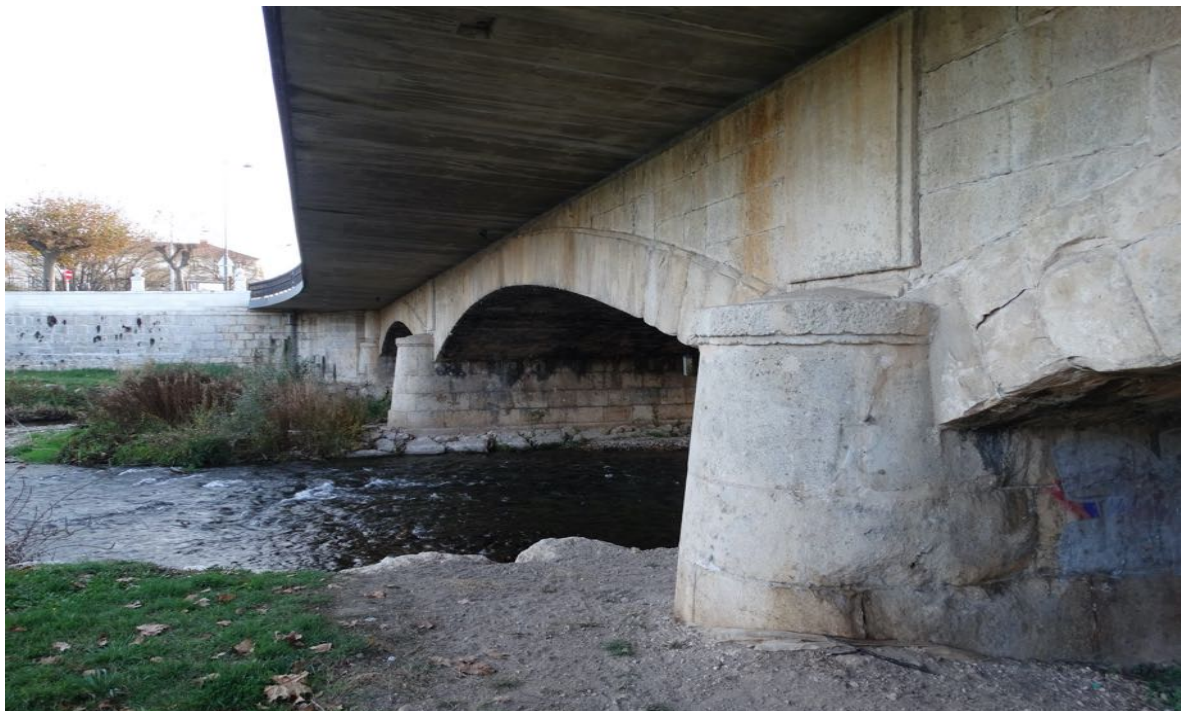
Figura 27: Vistas generales del puente una vez ampliado.
