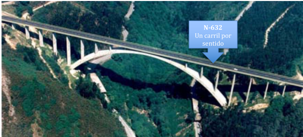
Figura 46: Vista general del viaducto anterior a la ampliación.
