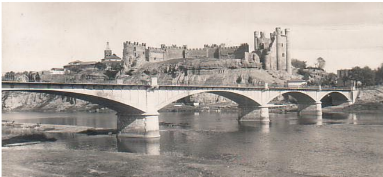
Figura 36: Vista general del puente anterior a la ampliación.
