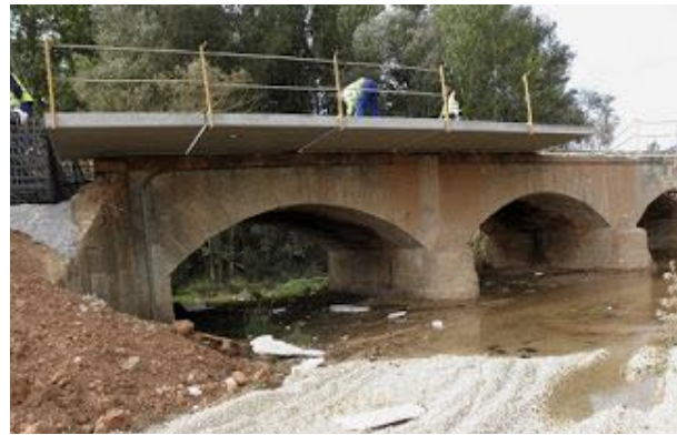
Figura 22: Izado y colocación de las losas prefabricadas. [12]
