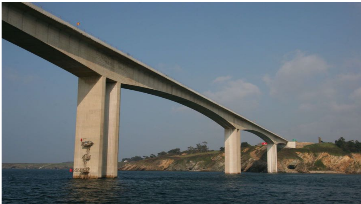
Figura 61: Vista de la magnitud del cajón central y de las dobles pilas en sección rectangular.
