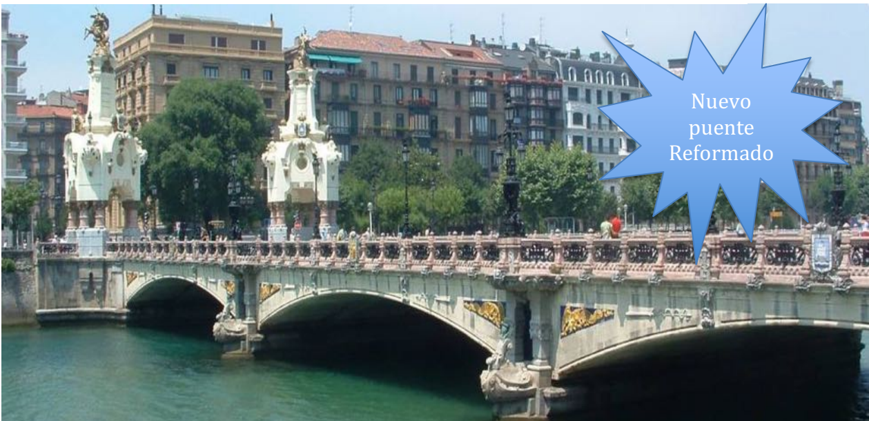
Figura 35: Vista general del nuevo Puente rehabilitado.
