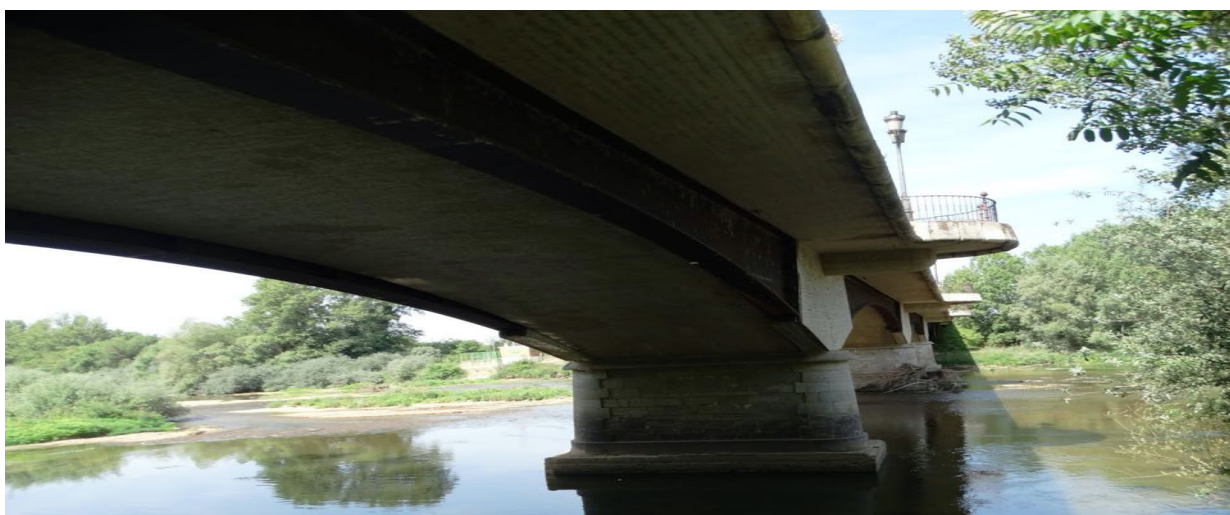
Figura 38: Diferentes vistas del puente tras la ampliación.
