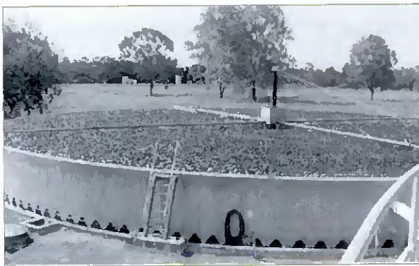
Fig.22- Filtro trickling com meio de gravilha e esquema dos seus componentes.
