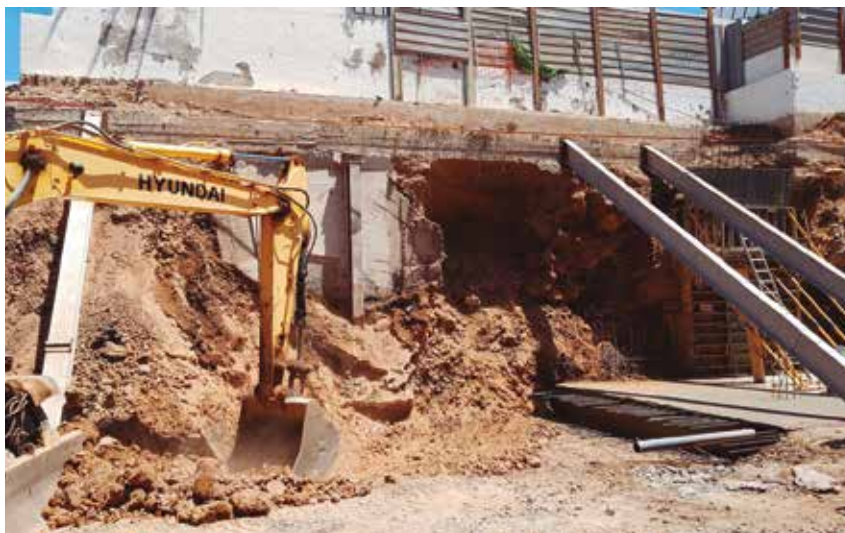
Apuntalamiento provisional de una medianera. Fotografía de Maximiliano Valero Padilla, 2020.
