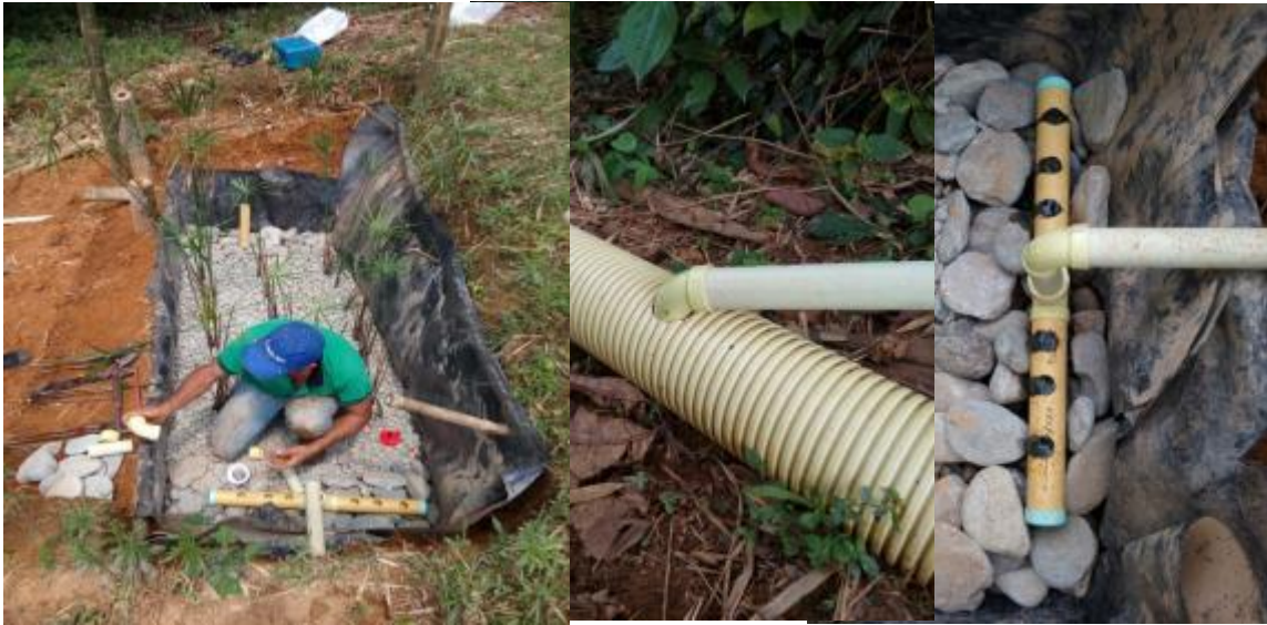
Figura 1: Instalación de canalizaciones de entrada y salida del agua residual.
