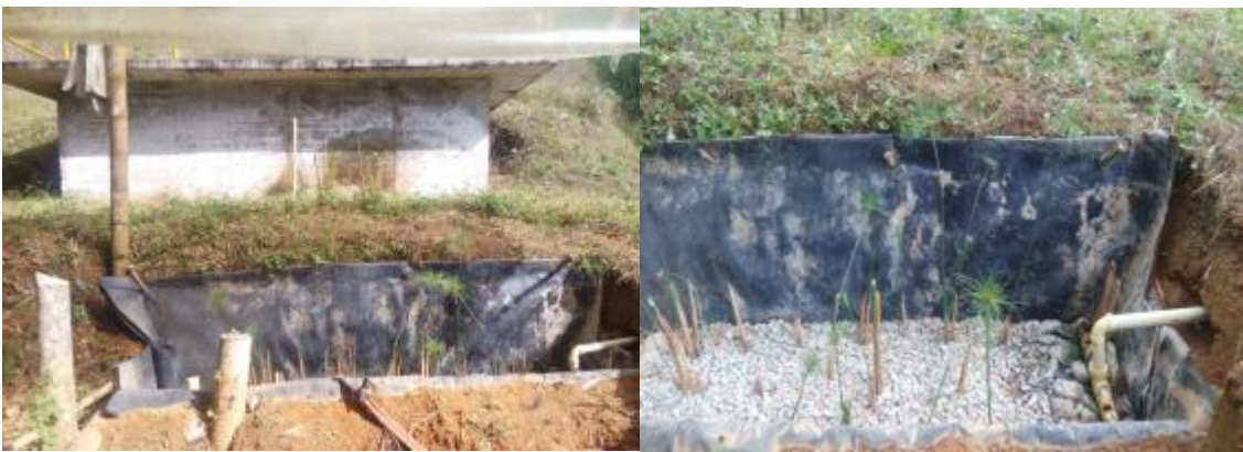
Figura 2: Canal de flujo horizontal con paredes ataludadas.
