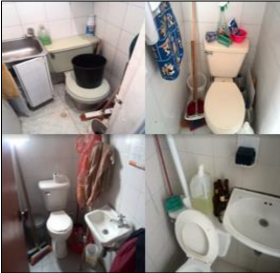
Figura 7. Uso inadecuado unidades sanitarias Fuente: los autores
