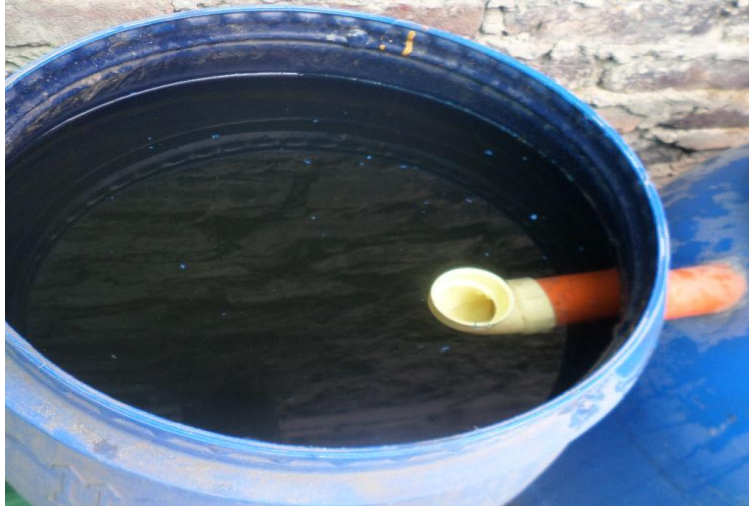
Imagen 24 Tubo de filtración
