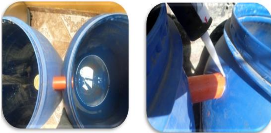
Imagen 19 Acoplamiento y sellado de tanques
