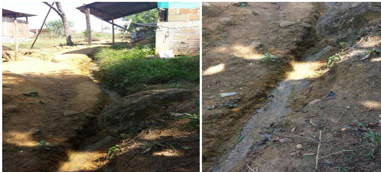
Fotografía 2. Cunetas para el paso de aguas servidas
