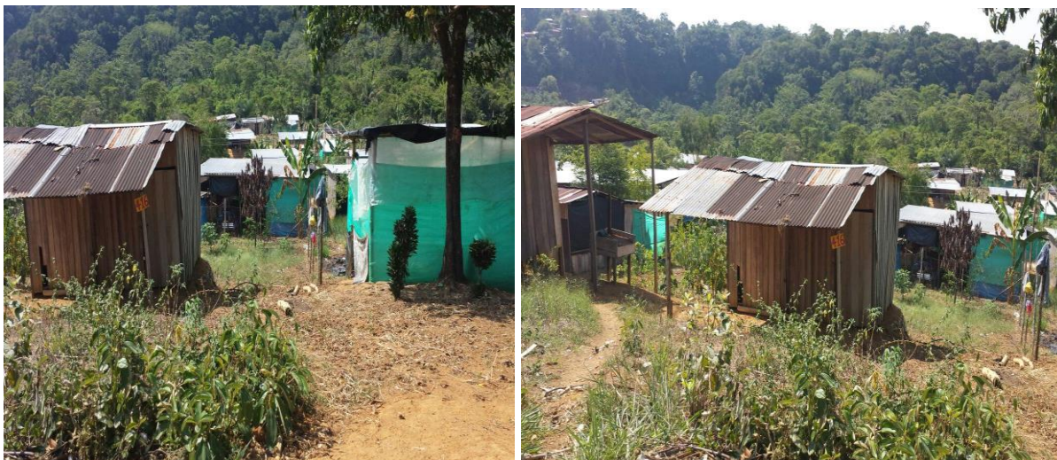
Fotografía 4. Condiciones de la mayoría de las viviendas del asentamiento
