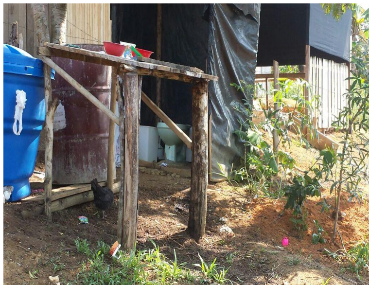
Fotografía 12. Eliminación directa de aguas servidas al suelo
