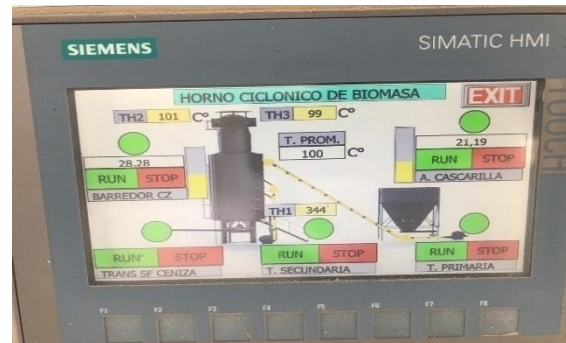
Foto 5: Control de medición para el proceso de secamiento en las torres
