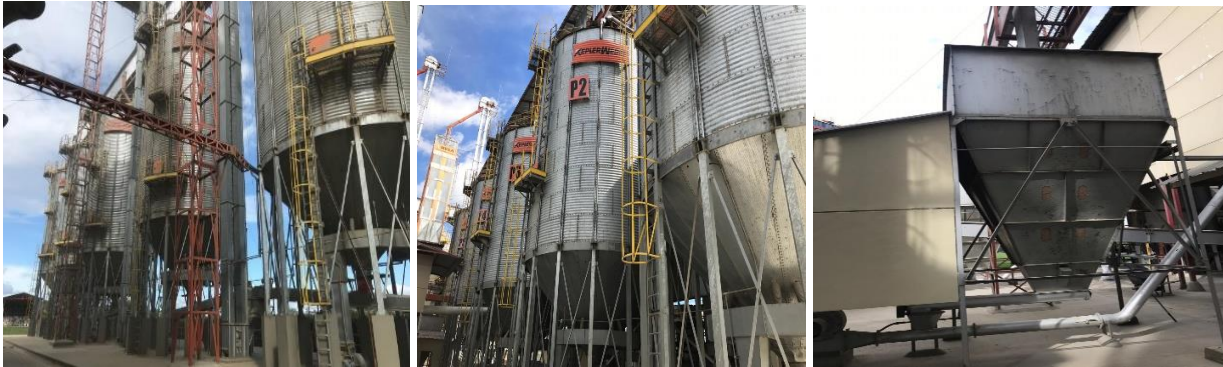
Foto No 1-3 Silos de reposo, Torres de secamiento, Tolvas para depositar cascarilla de Arroz para producir energía calórica en el proceso de secamiento
