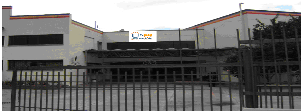
Foto 1. Instalaciones del CEAD JAG
